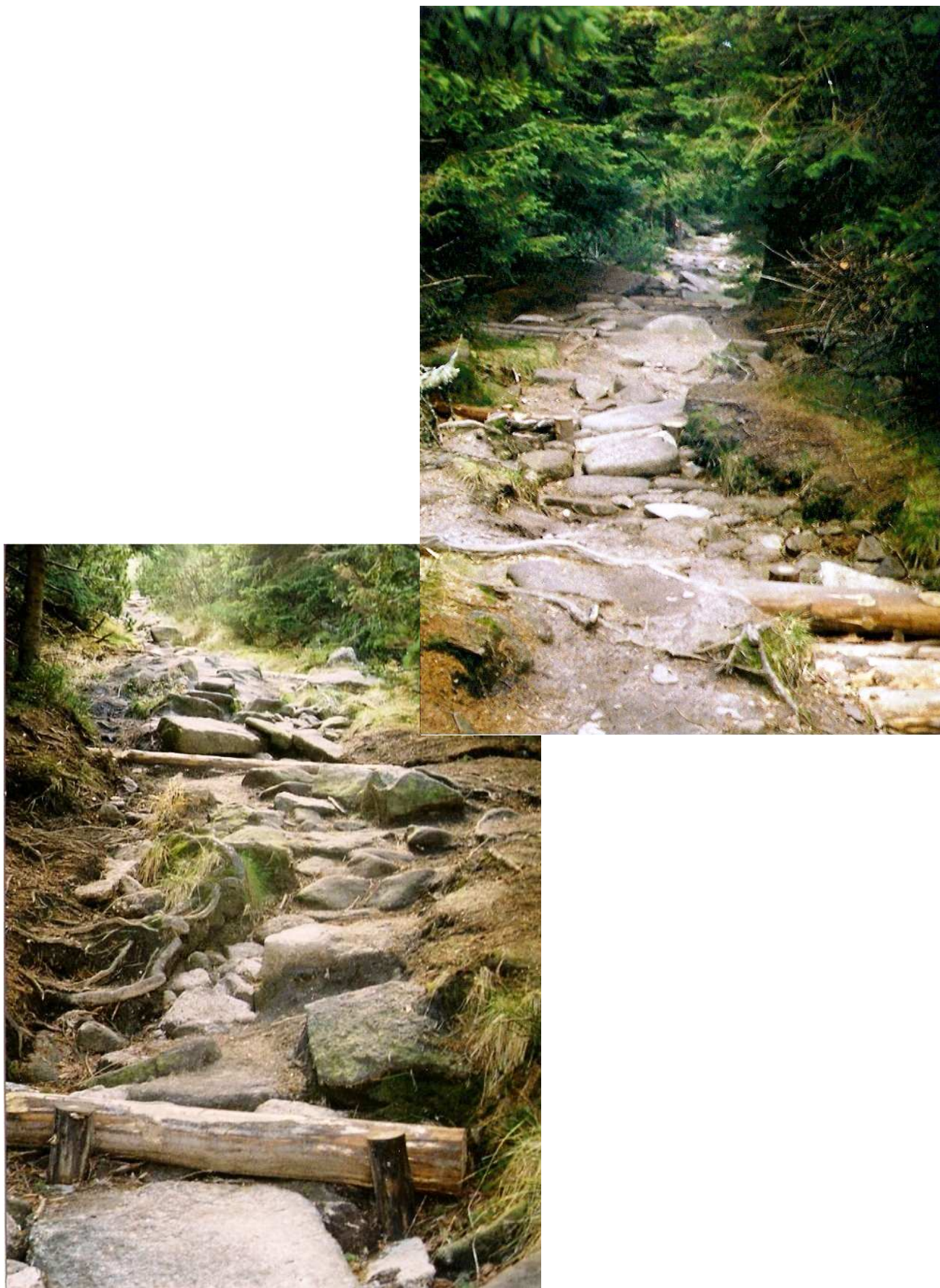
Fot. 13, 14, 15 i 16. Odcinek III – zniszczona nawierzchnia szlaku.
