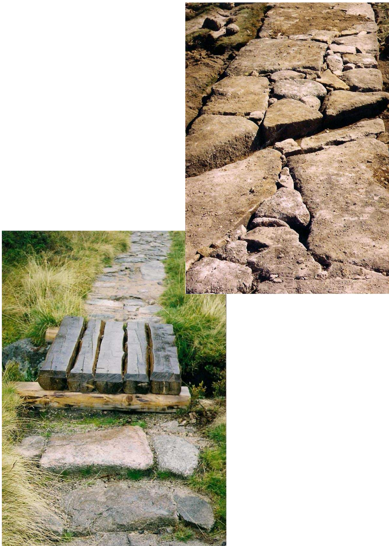
Fot. 34 i 35. Przykładowe rozwiązania przepustów kamiennych; odkryty i z pomostem drewnianym
