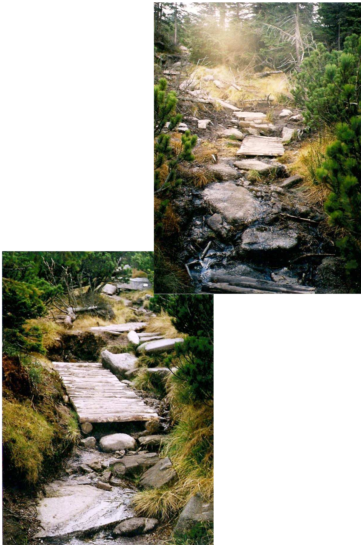
Fot. 19 i 20. Odcinek IV – zniszczone pomosty drewniane.
