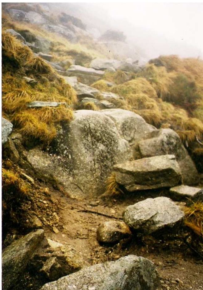
Fot. 12, 13, 14, 15, 16, 17 i 18 . Zniszczona nawierzchnia z kamienia miejscowego
