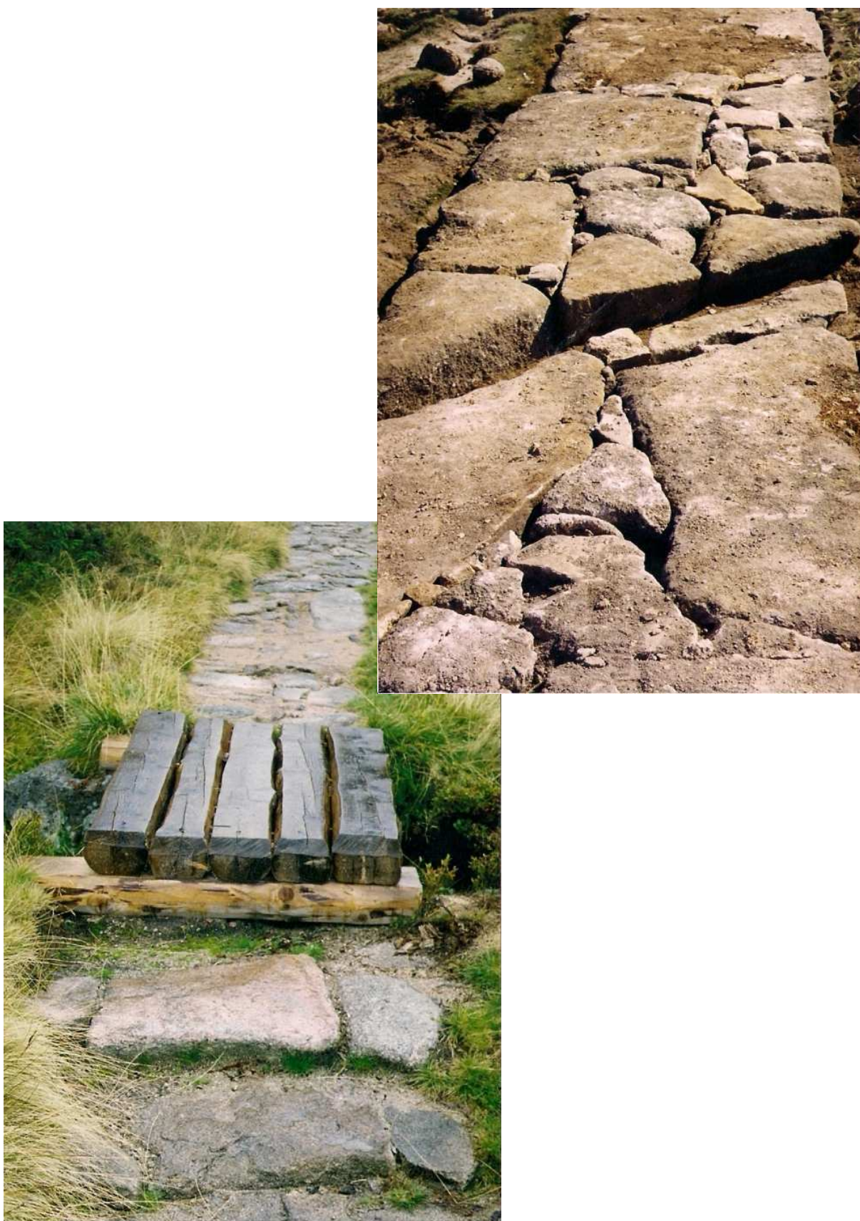
Fot. 26 i 27. Przykładowe rozwiązania przepustów kamiennych; odkryty i z pomostem drewnianym.
