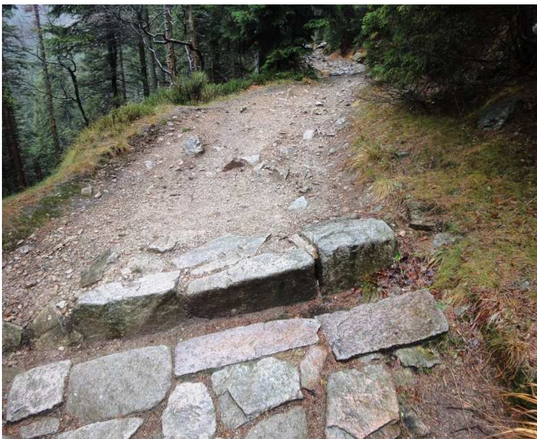
Fot. 4 i 5. Udrożnione i odbudowane przepusty kamienne – odkryte.
