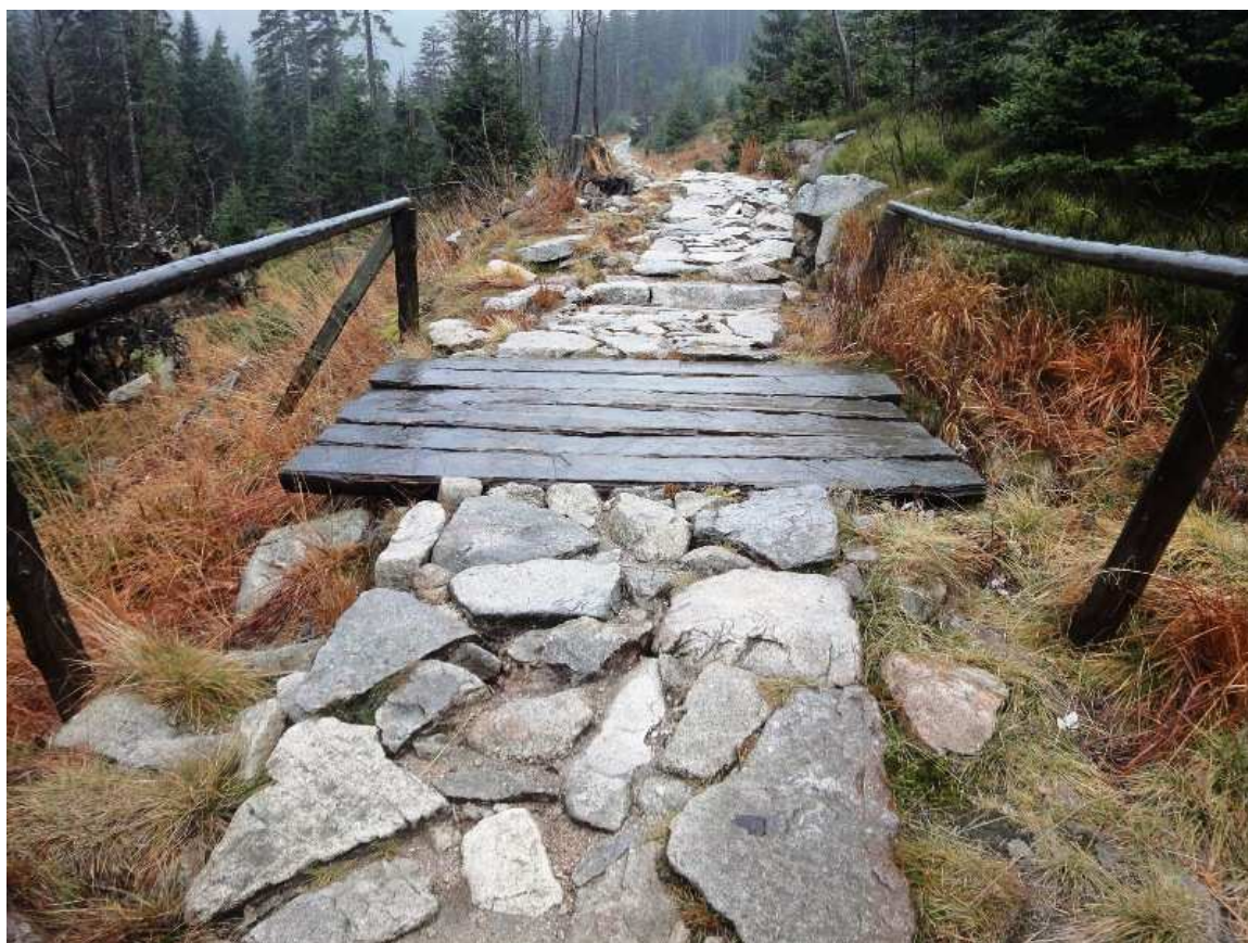
Fot.2 i 3. Odbudowana brukowana nawierzchnia szlaku z kamienia miejscowego.
