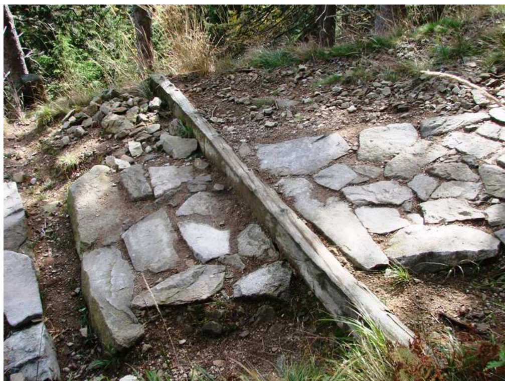
Fot.6. Progi drewniane.
