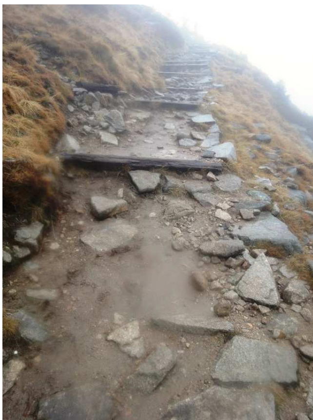
Fot.19. Zniszczona zabudowa drewniano-kamienna.
