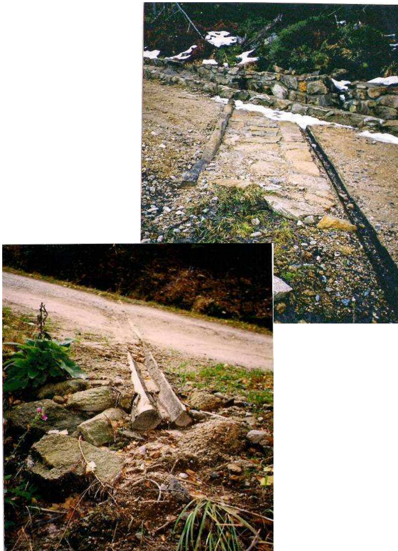
Fot.2. Podwójne (wzmocnione) i pojedyncze progi drewniane.
