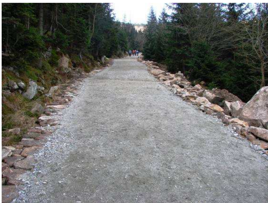
Fot.16. Nawierzchnia tłuczniowa.
