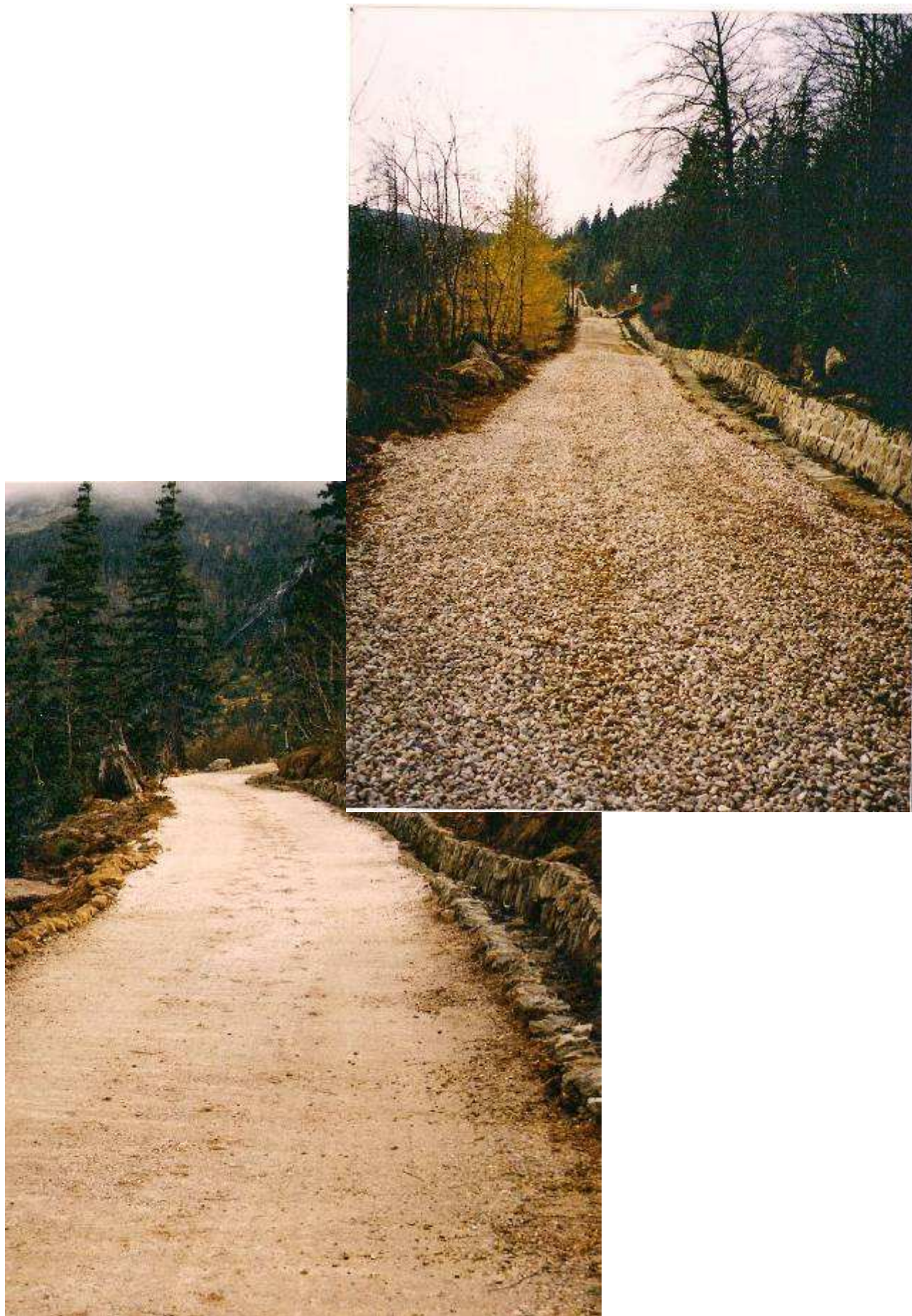
Fot.1. Nawierzchnia tłuczniowa.
