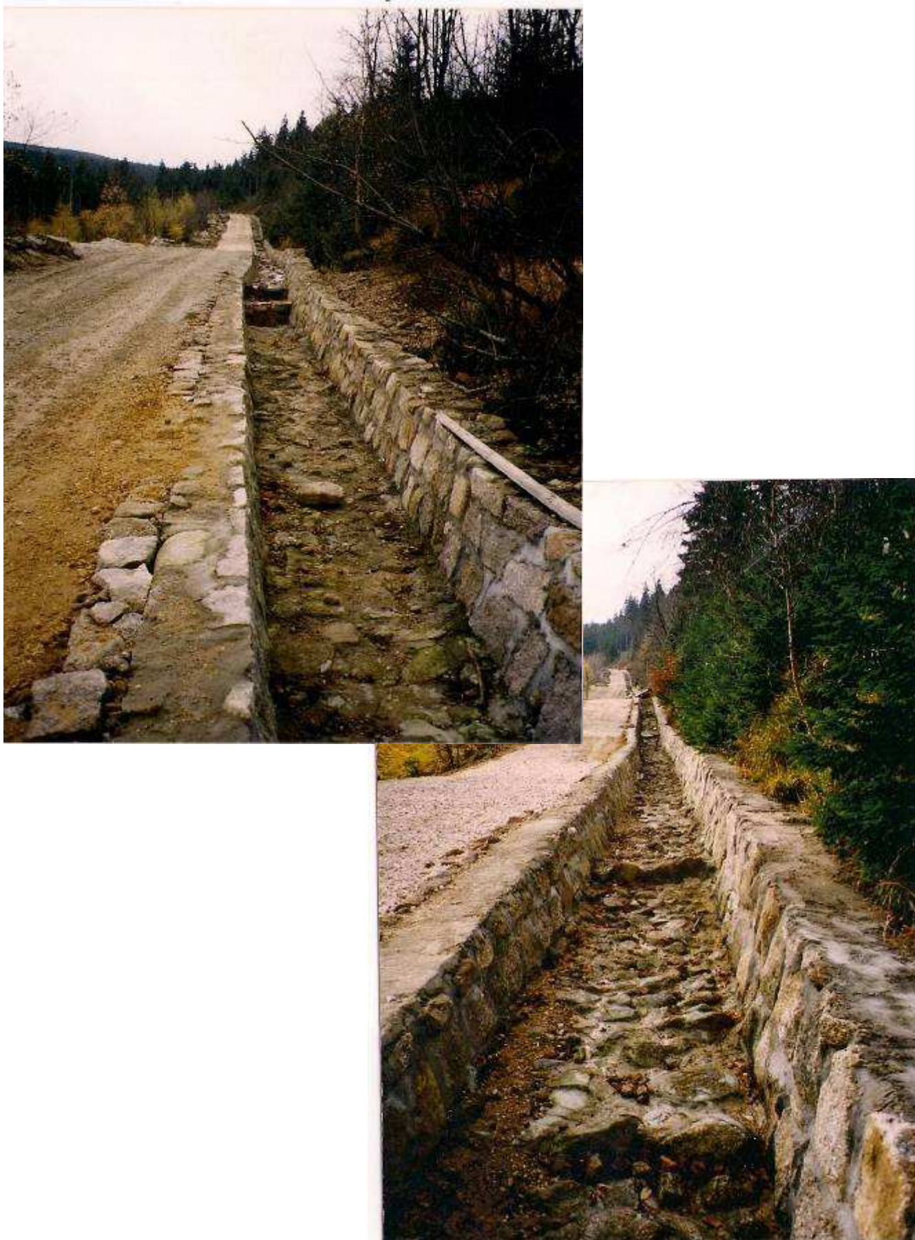
Fot. 3. Rów odstokowy murowany z kamienia, dno wyłożone kamieniem na betonie.
