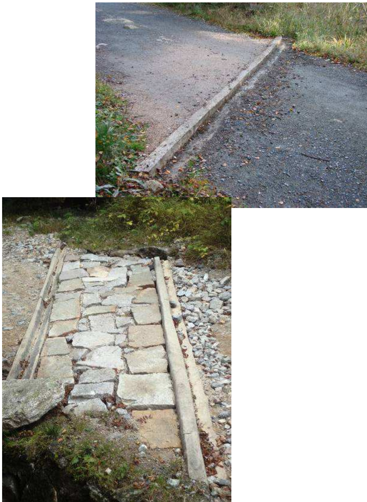
Fot.18. Progi wzmacniające nawierzchnię szlaku.
