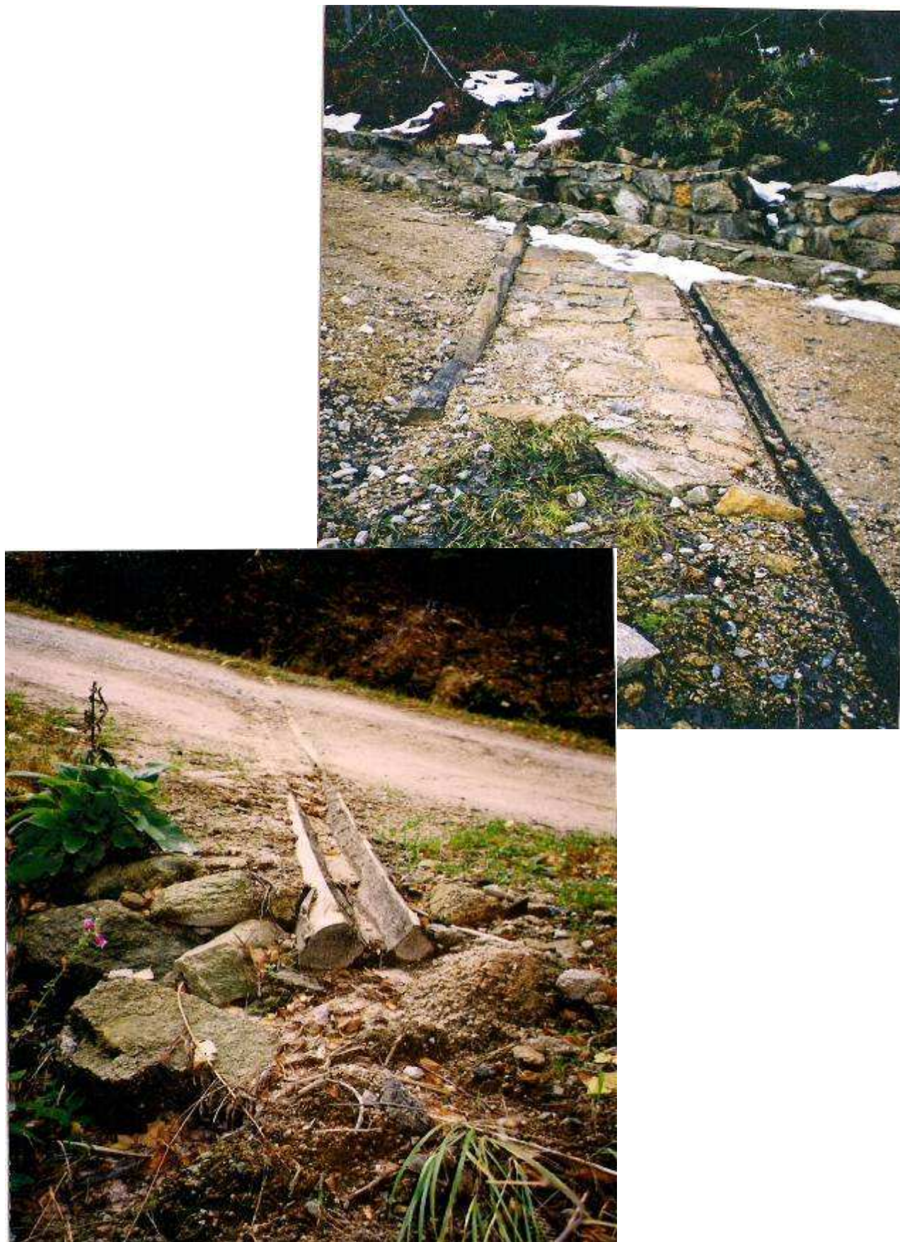
Fot.2. Podwójne (wzmocnione) i pojedyncze progi drewniane.
