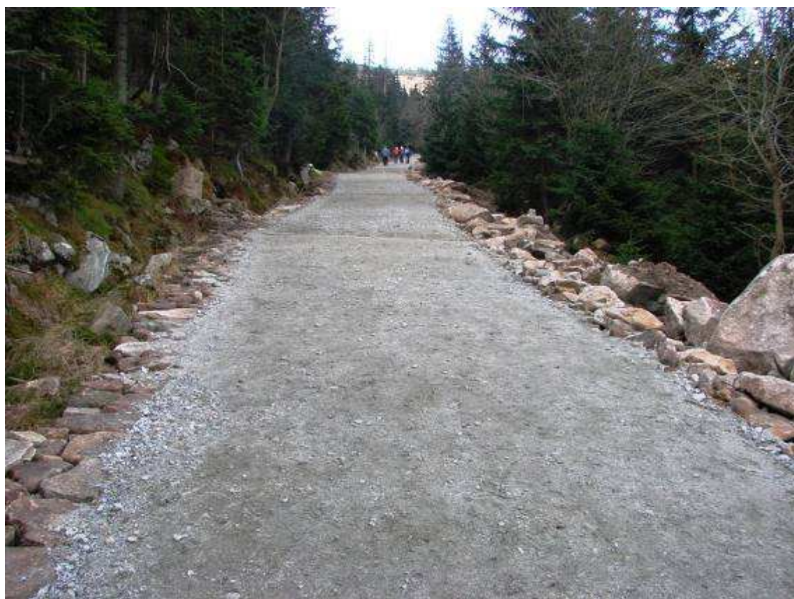
Fot.16. Nawierzchnia tłuczniowa.
