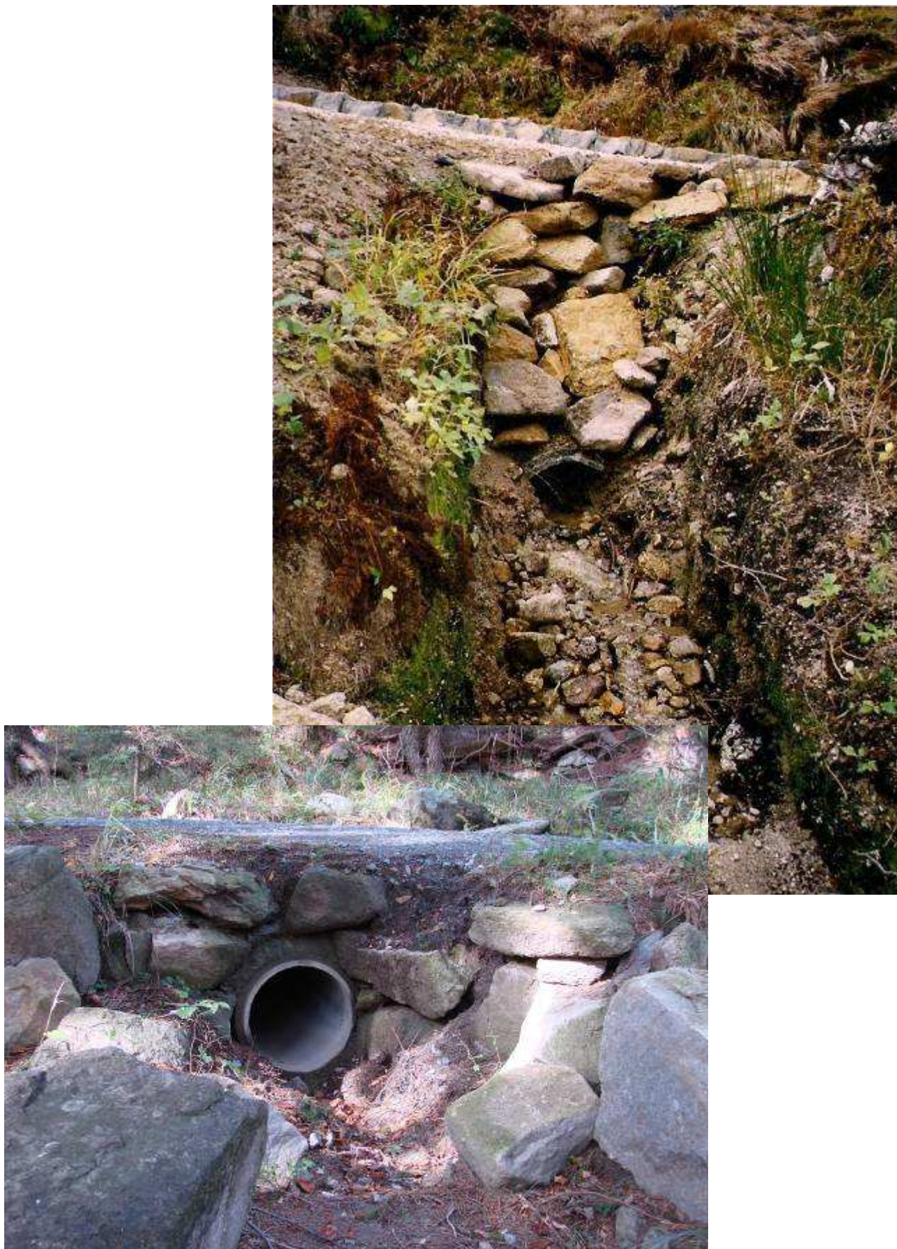
Fot.5. Wylot przepustu z rur betonowych i rów odprowadzający wodę.
