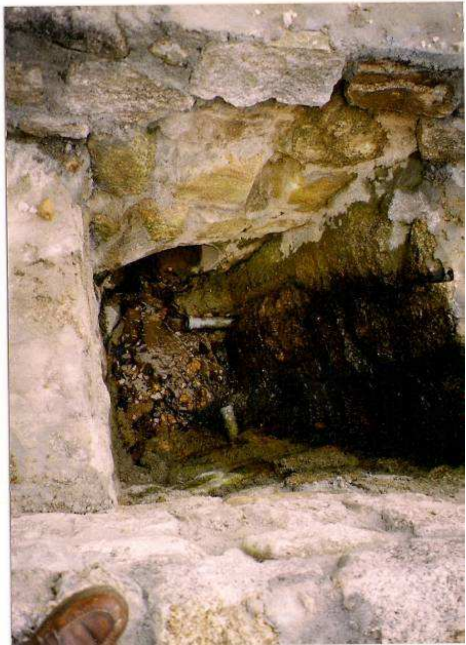
Fot.4. Wlot do przepustu, studzienka z odstojnikiem murowana z kamienia na zaprawie cementowej.
