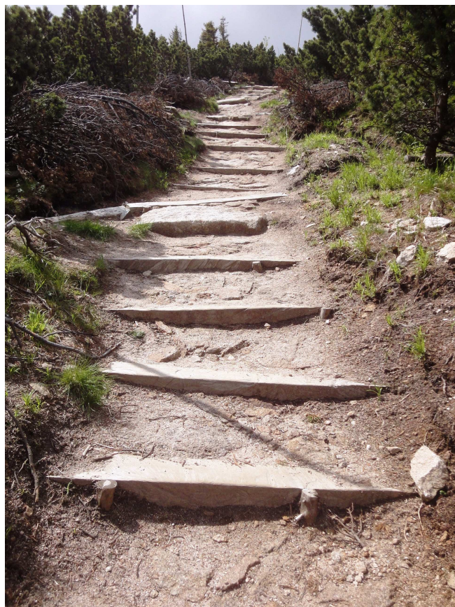
Fot. 7. Przykładowe drewniane stopnie terenowe wbudowane w nawierzchnię szlaku.
