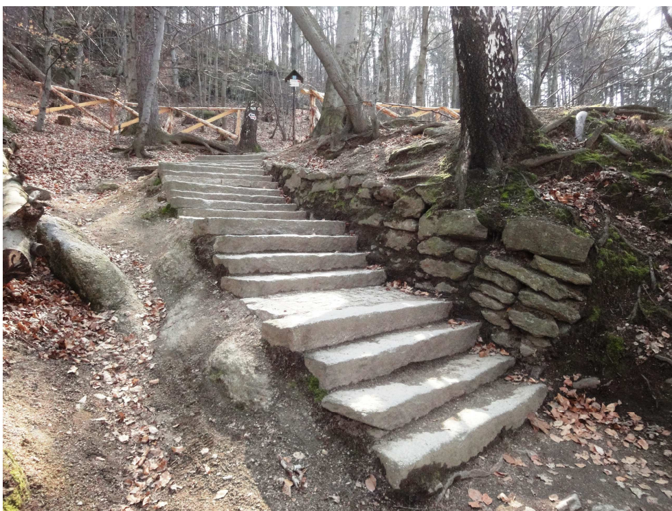
Fot.2. Schody terenowe na gruncie.
