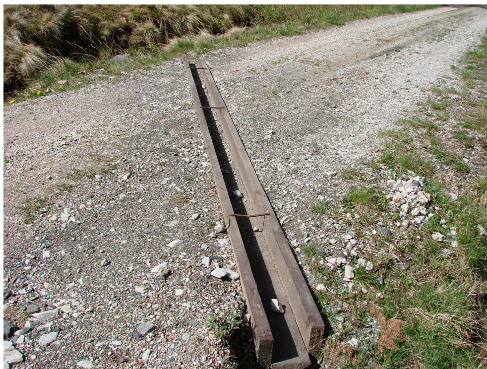
Fot. 5 i 6. Wodospusty drewniane wbudowany w nawierzchnię.
