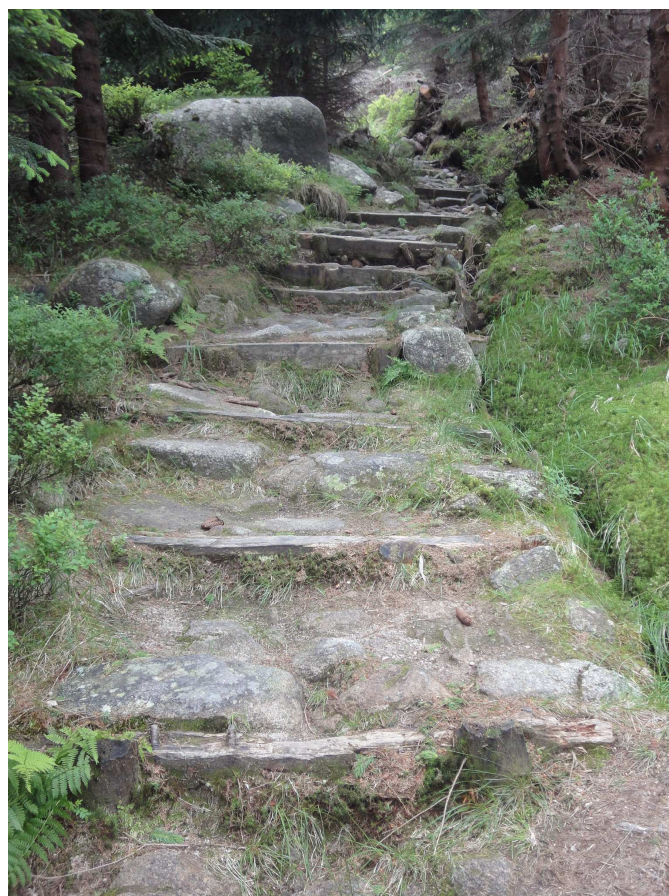
Fot. 10, 11 i 12. Zniszczone rowy i pobocza szlaku..
