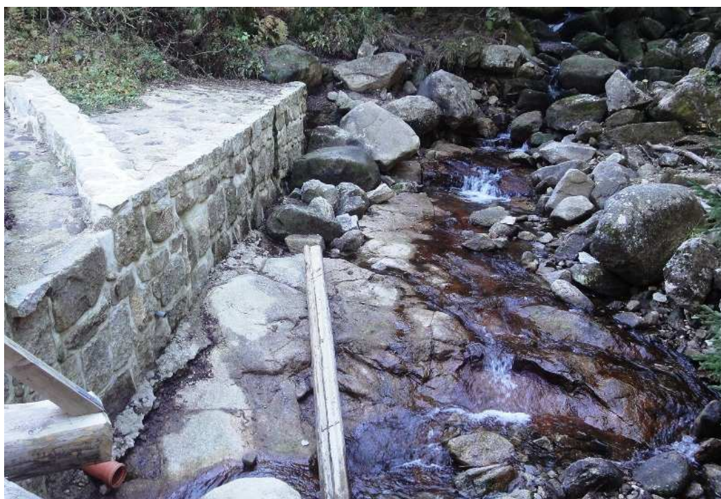
Fot.4 i 5. Mur oporowy z kamienia na zaprawie cementowej
