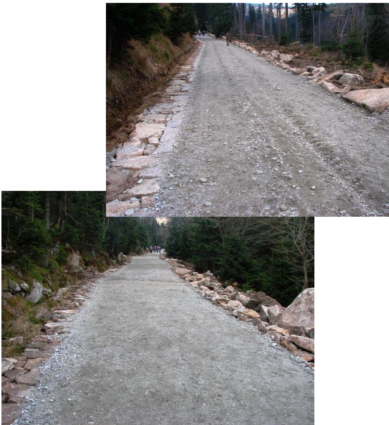
Fot. 8 i 9. Przykłady nawierzchni tłuczniowej.
