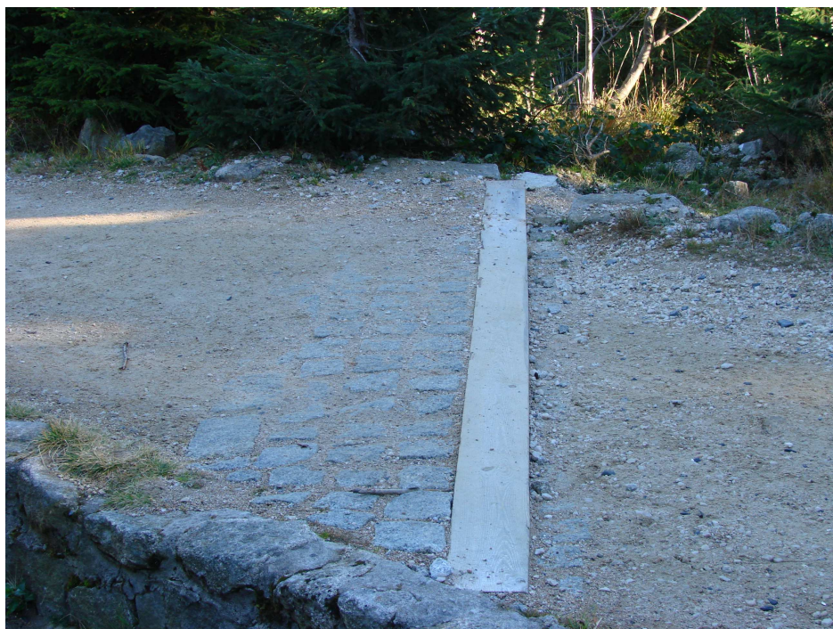
Fot. 10. Progi drewniane wbudowane w nawierzchnię tłuczniową.
