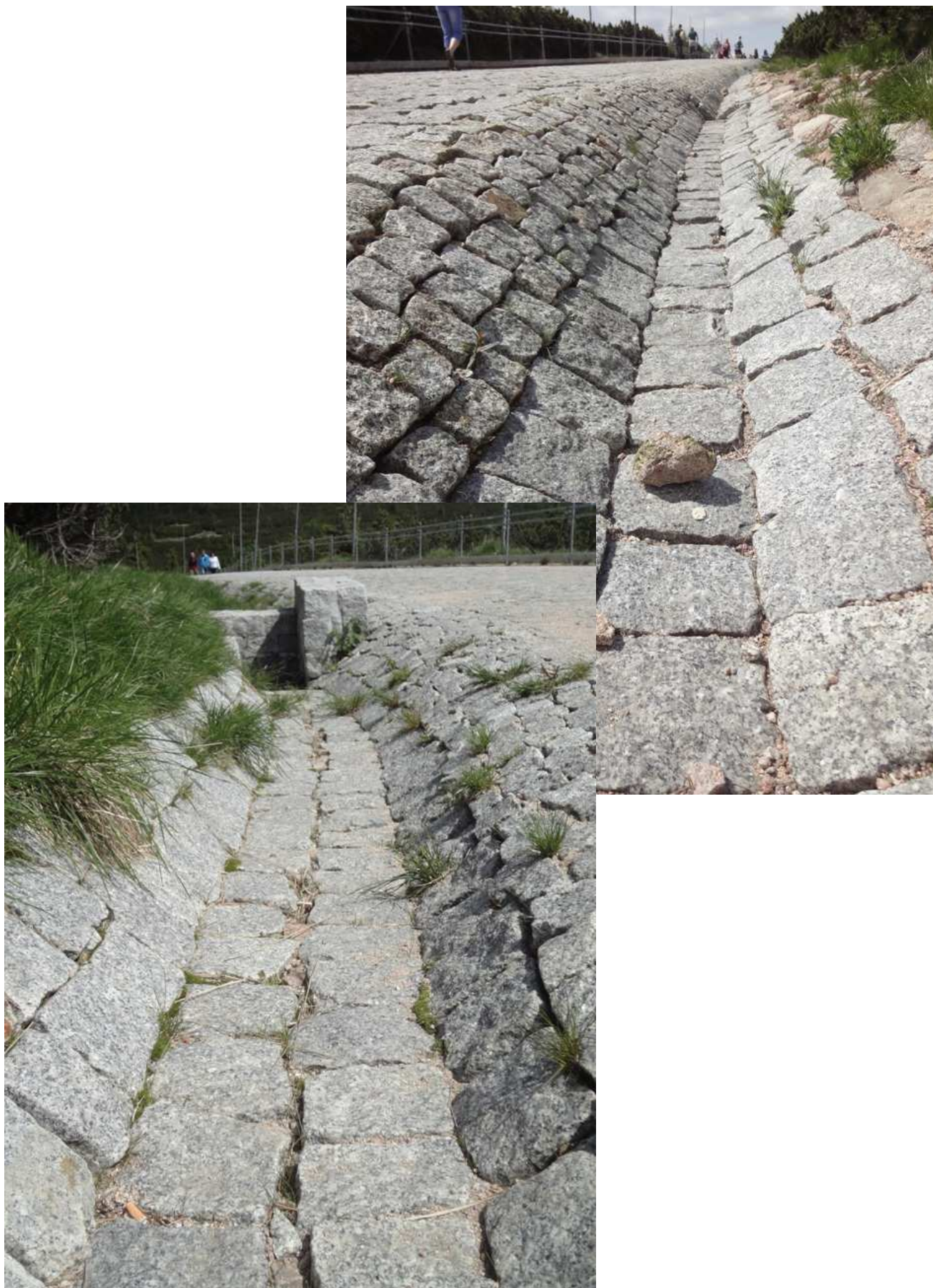
Fot.21. Wylot przepustu.
