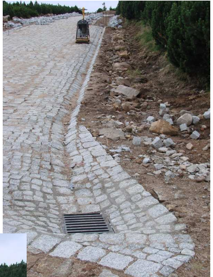
Fot.16, 17 i 18. Wpust do przepustu betonowego pod nawierzchnią drogi.
