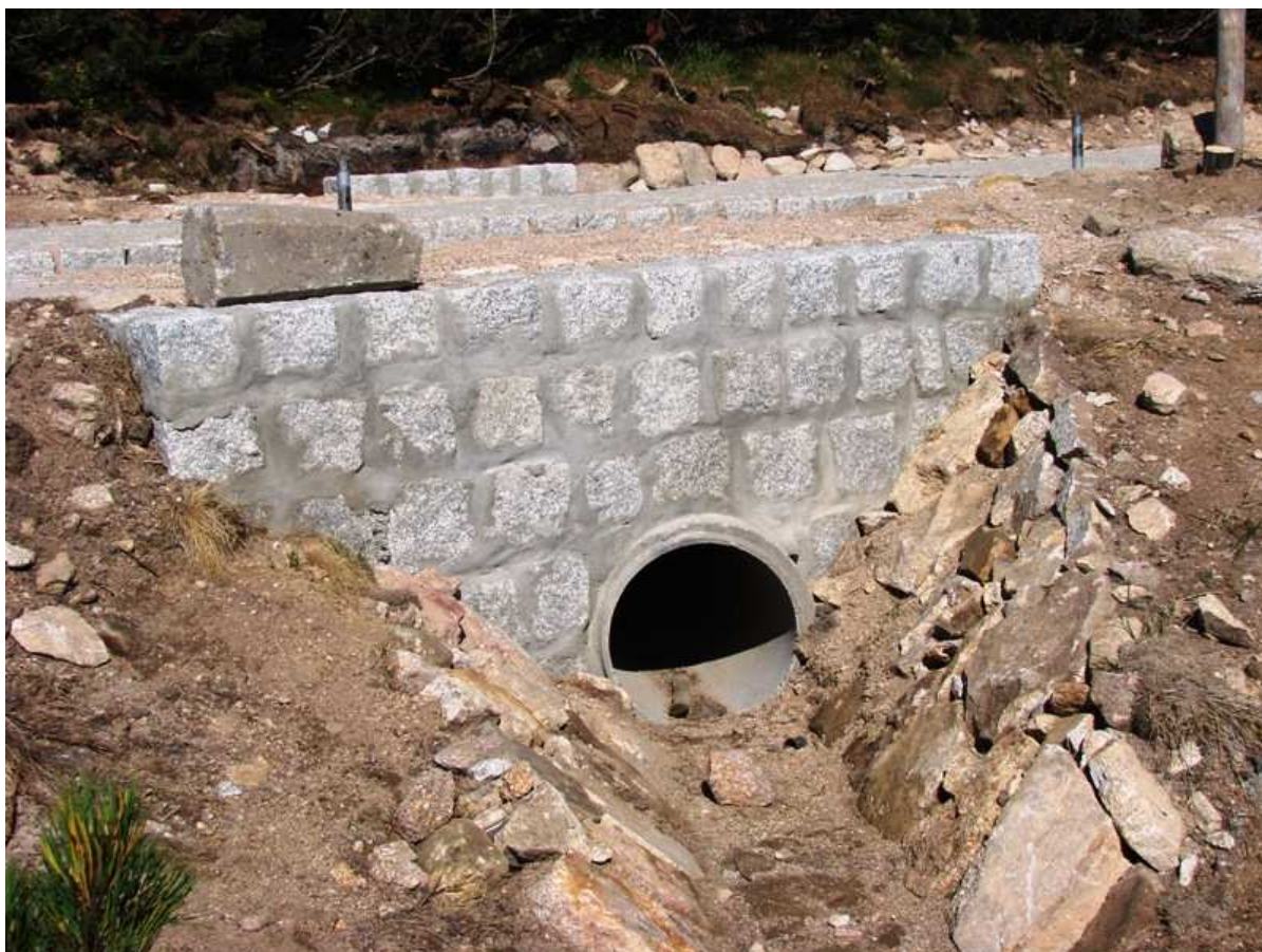
Fot.20. Próg kamienny z wlotem studzienki i przepustu.
