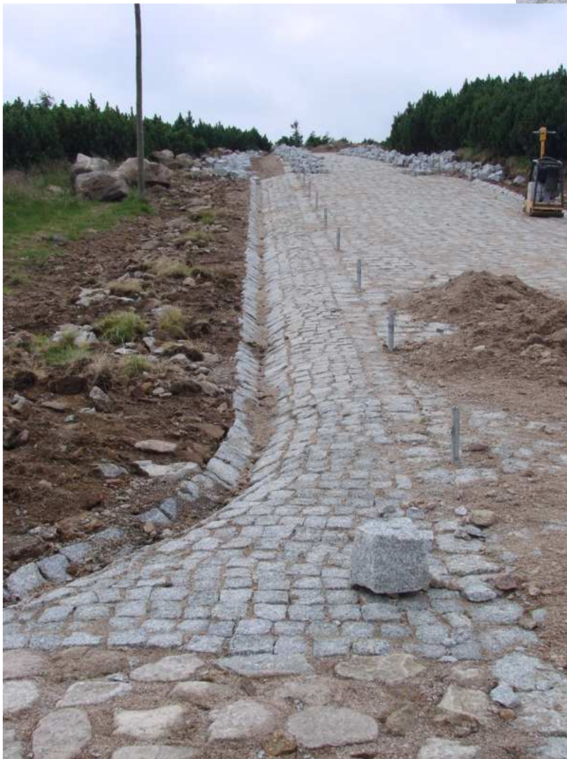
Fot.16, 17 i 18. Wpust do przepustu betonowego pod nawierzchnią drogi.
