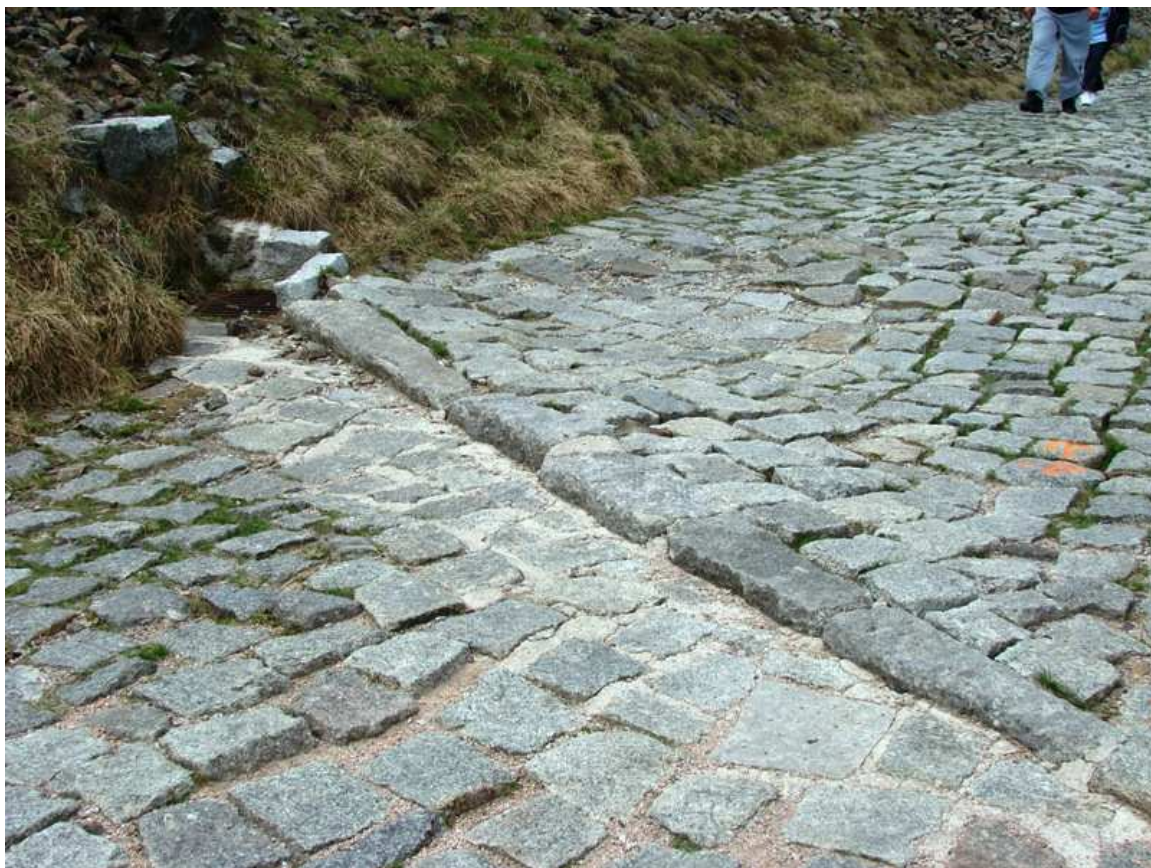
Fot.20. Próg kamienny z wlotem studzienki i przepustu.
