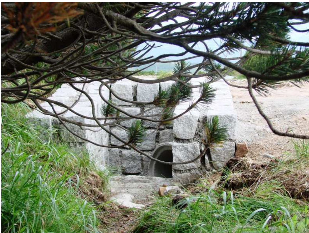
Fot.22 i 23. Ścieki brukowane.
