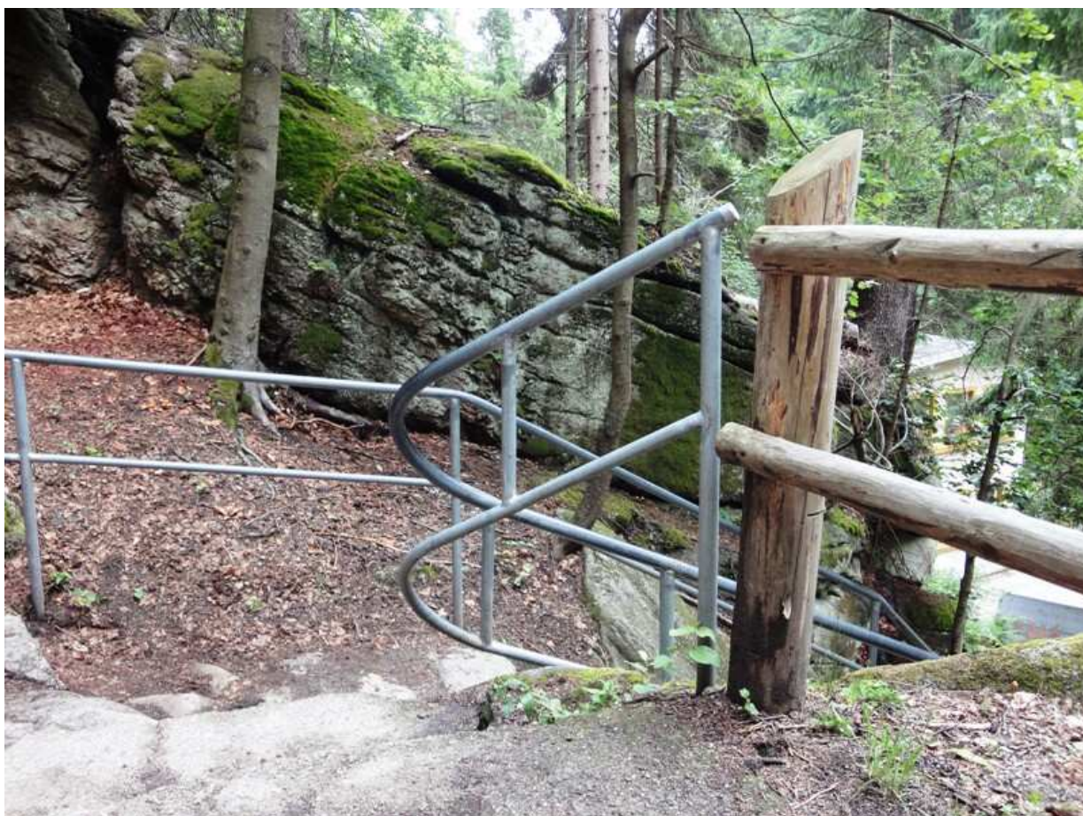
Fot.5. Miejsce połączenia nowych balustrad z już istniejącymi.
