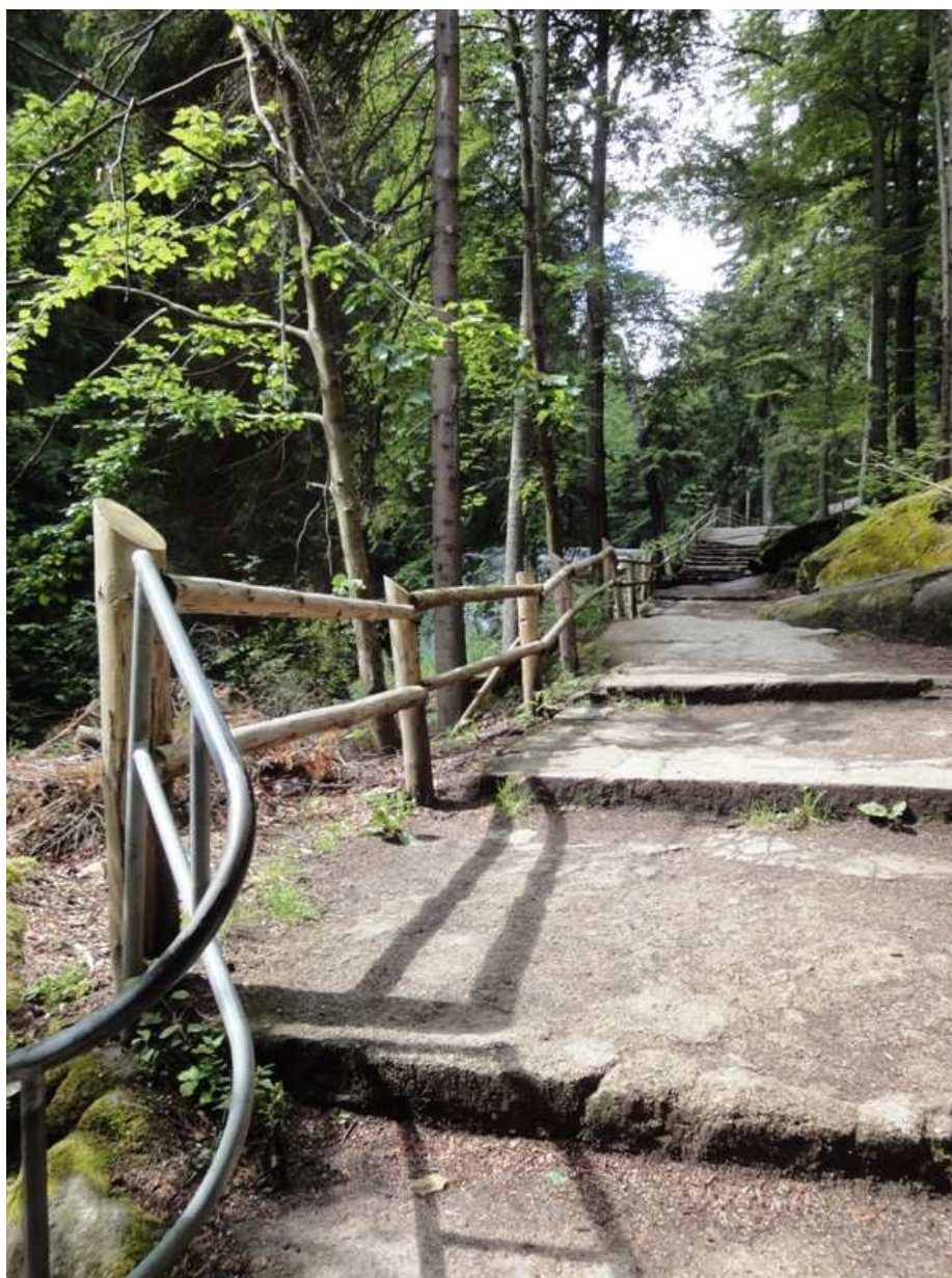
Fot.1. Początek odcinka do wymiany ogrodzenia.
