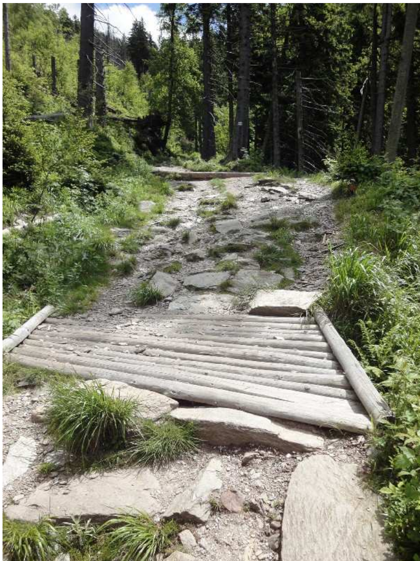
Fot. 5, 6, 7 i 8. Zniszczone pomosty nad przepustami kamiennymi.
