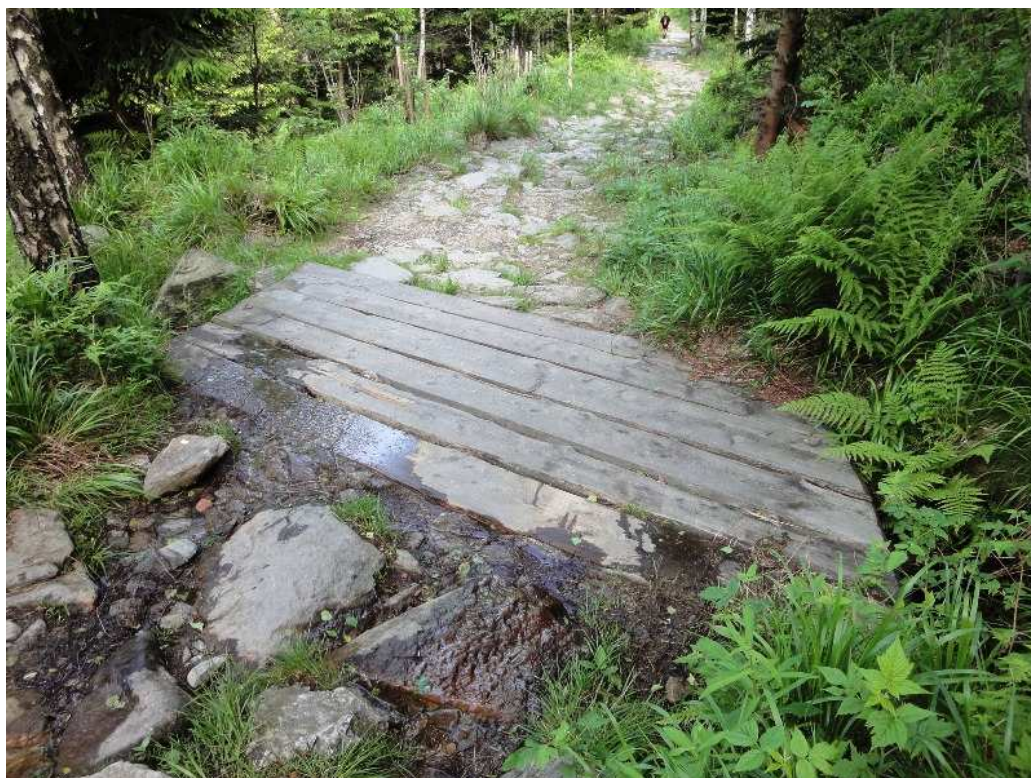
Fot. 10. Wymienione kładki nad przepustami.
