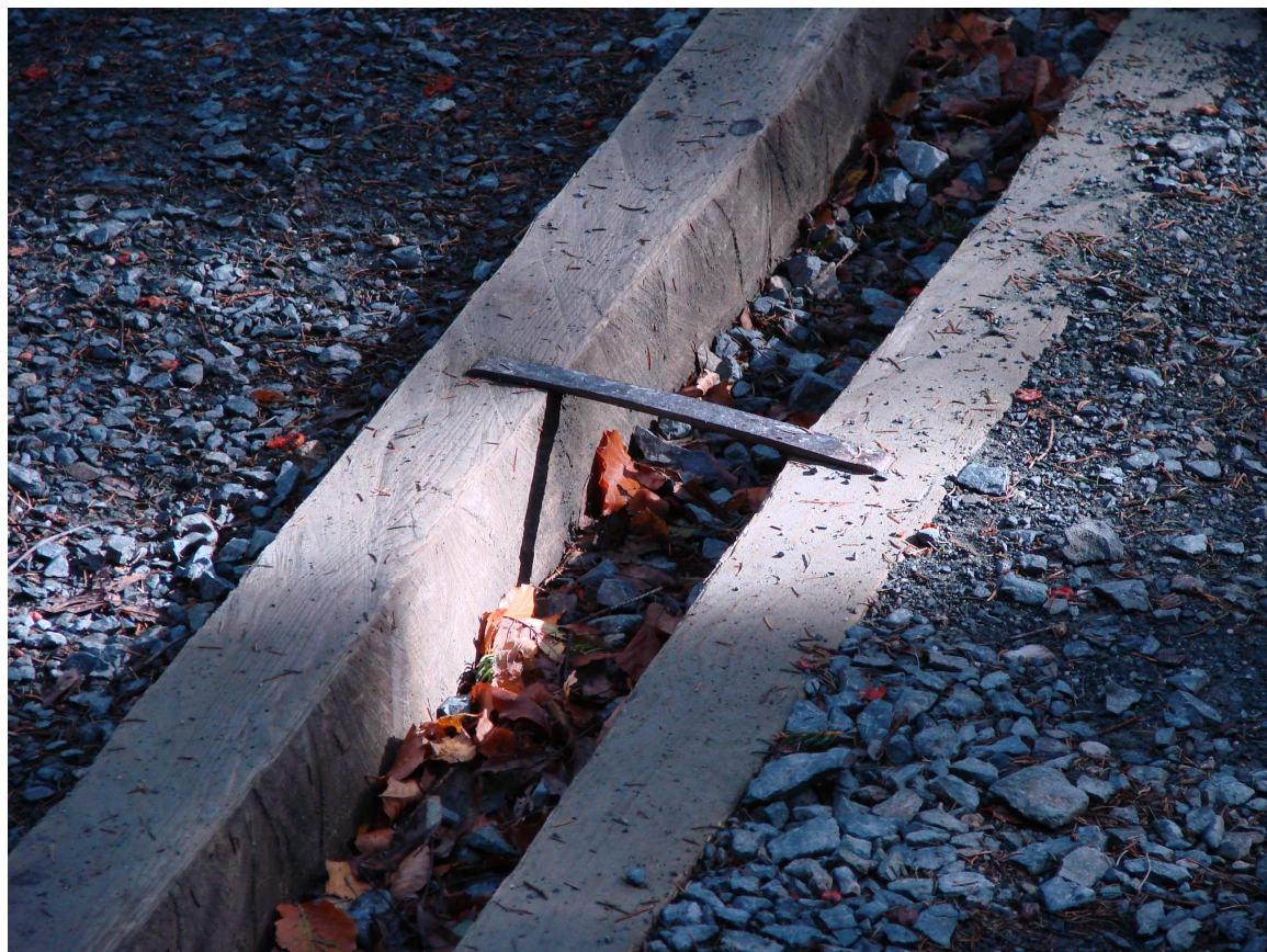
Fot. 26. Przykładowe rozwiązania przepustów odkrytych z drewna.
