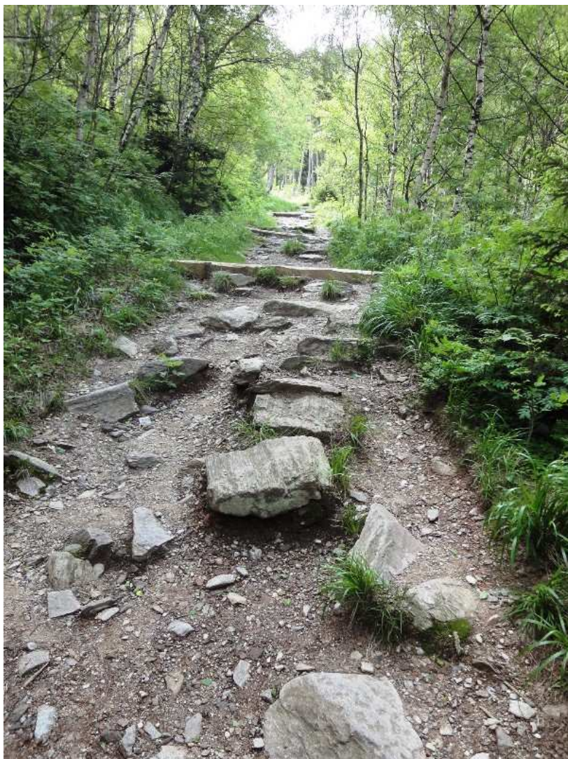
Fot.1, 2, 3 i 4. Zniszczona nawierzchnia brukowana kamieniem miejscowym.
