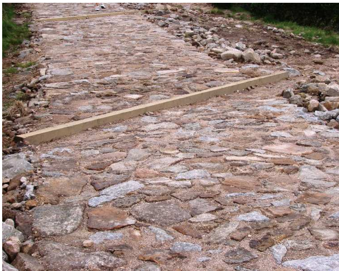
Fot. 26. Przykładowe rozwiązania przepustów odkrytych z drewna.
