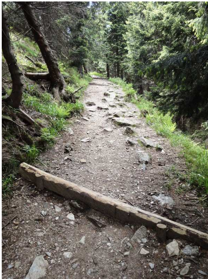
Fot. 11. Wbudowane w nawierzchnię progi i łapacze drewniane
