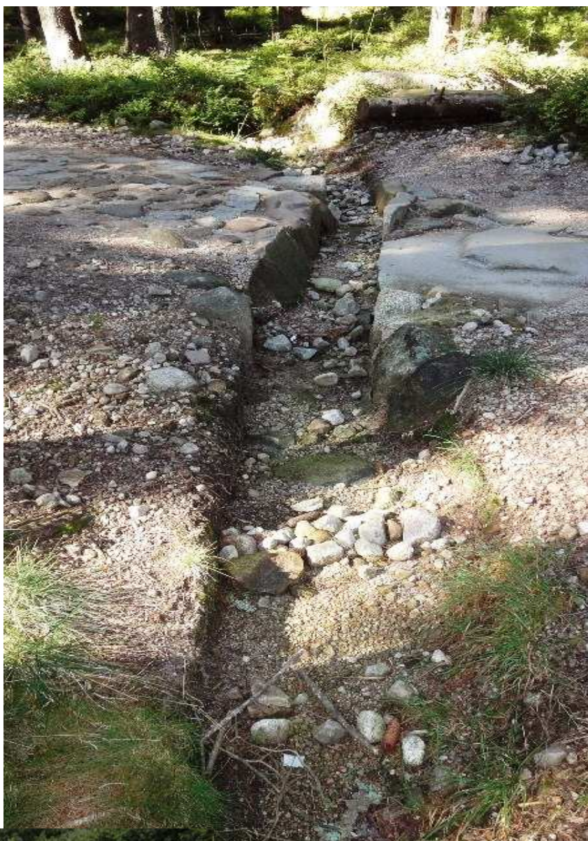
Fot. 24 i 25. Stopnie i progi wbudowane w nawierzchnię z kamienia miejscowego.
