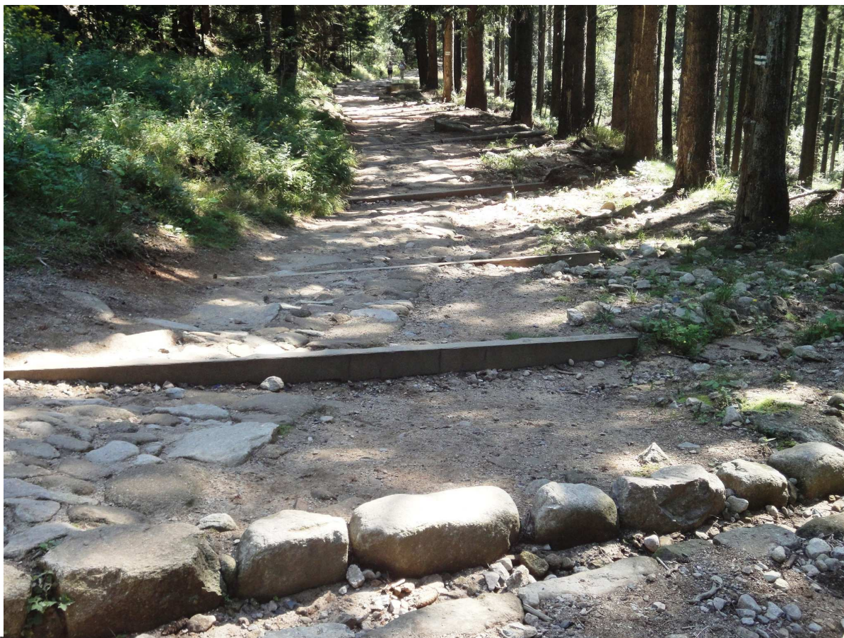
Fot. 20, 21, 22 i 23. Odbudowana brukowana nawierzchnia szlaku
