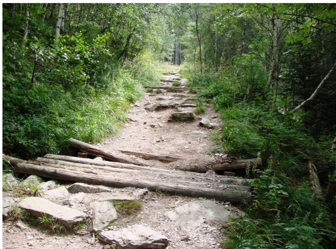
Fot.1, 2, 3 i 4. Zniszczona nawierzchnia brukowana kamieniem miejscowym.
