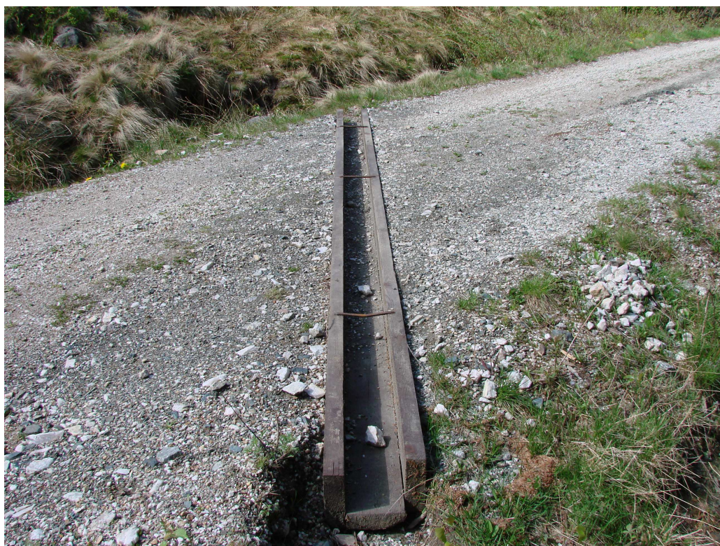
Fot. 10. Progi drewniane wbudowane w nawierzchnię tłuczniową.
