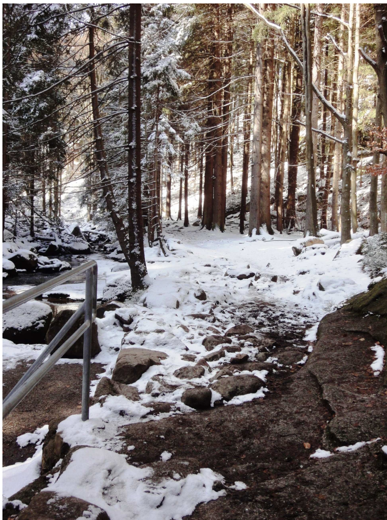
Fot.3. Miejsce połączenia projektowanych balustrad z już istniejącymi.
