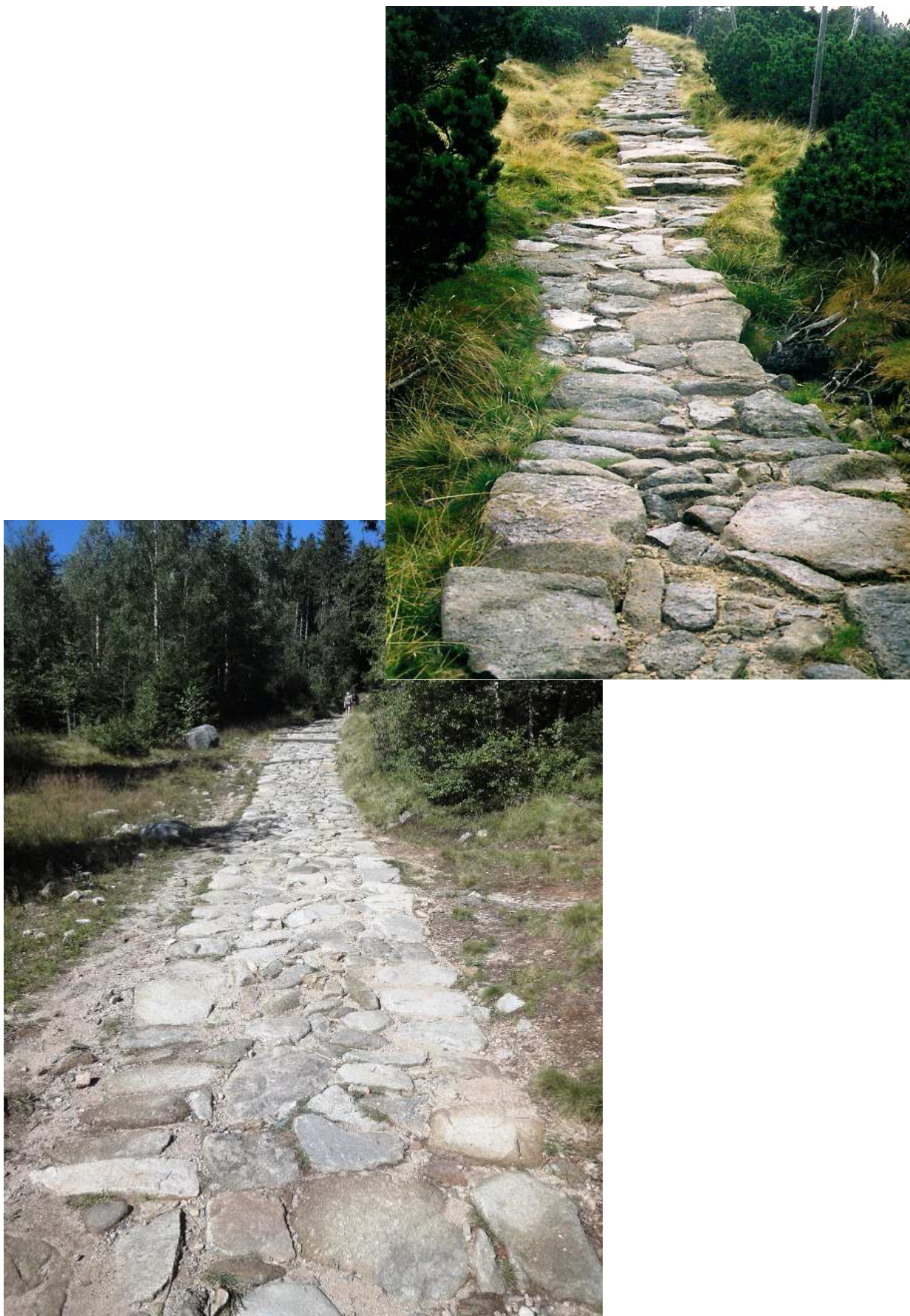
Fot. 17, 18 i 19. Odbudowa nawierzchni brukowanej z kamienia łamanego – PRACOWNIA PROJEKTOWA
