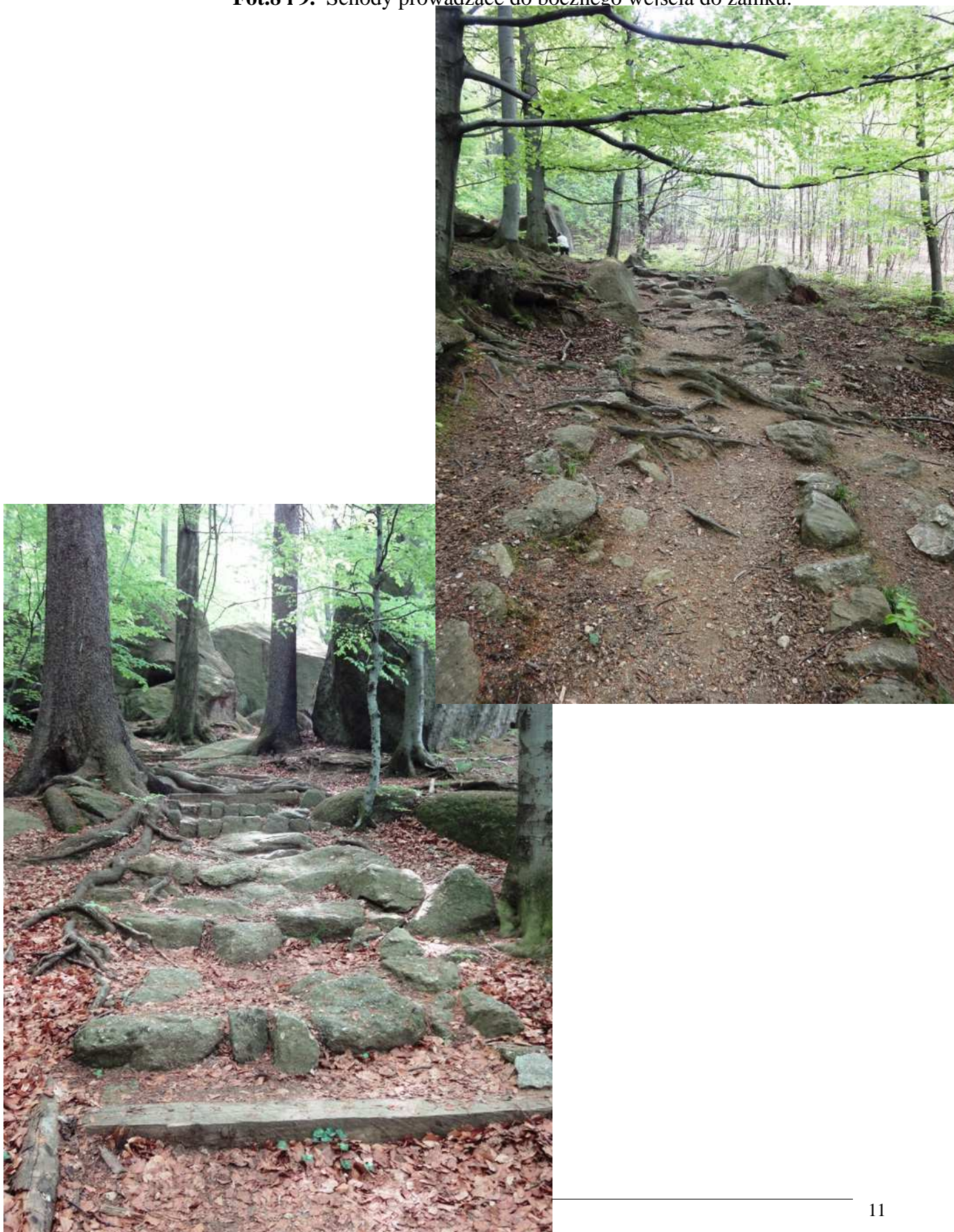
Fot.8 i 9. Schody prowadzące do bocznego wejścia do zamku.
