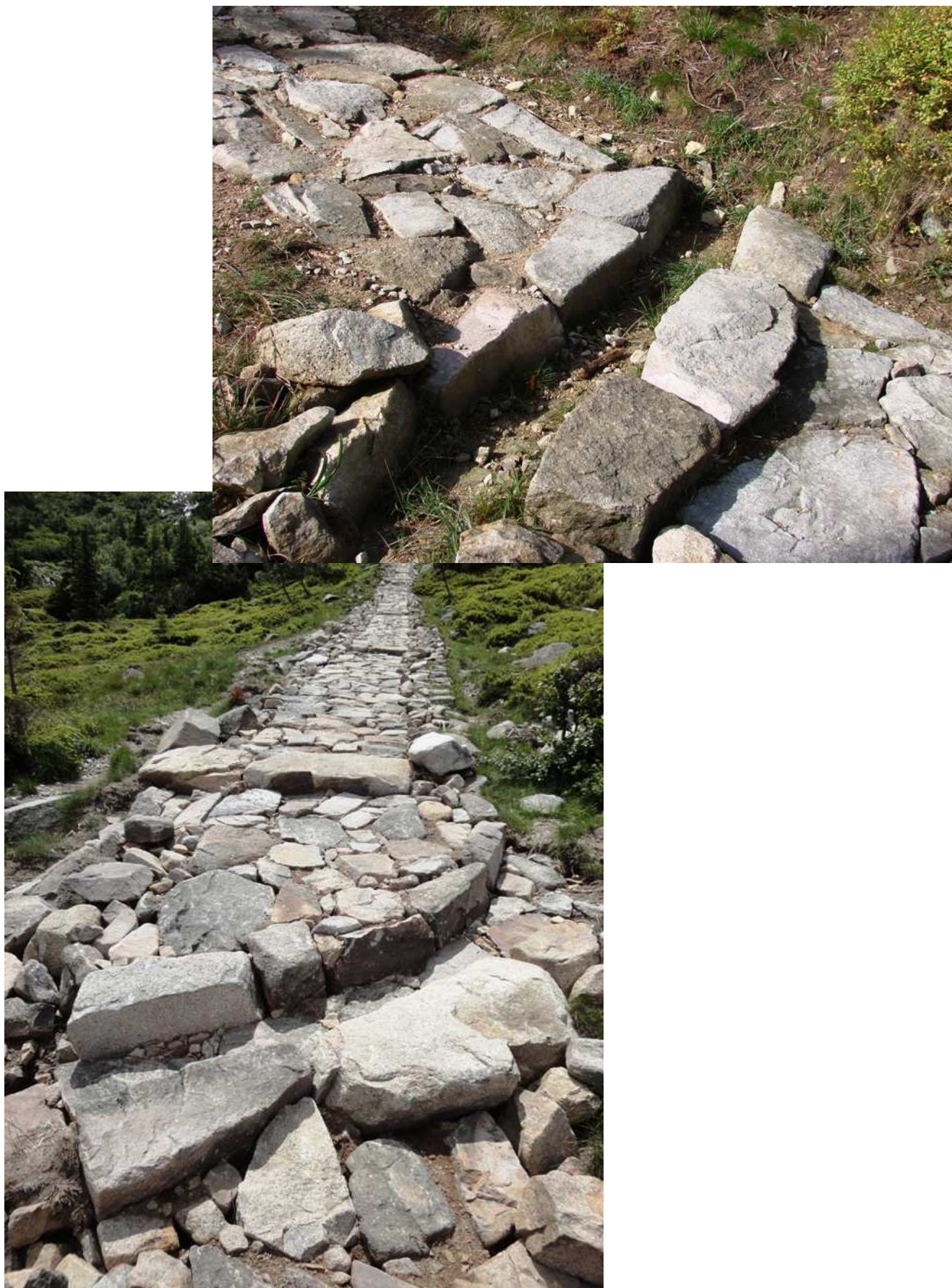
Fot.20. Przykładowe rozwiązania przepustów kamiennych odkrytych.
