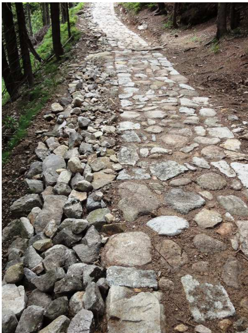
Fot.21. Zabezpieczenie poboczy szlaku drobnym materiałem kamiennym.
