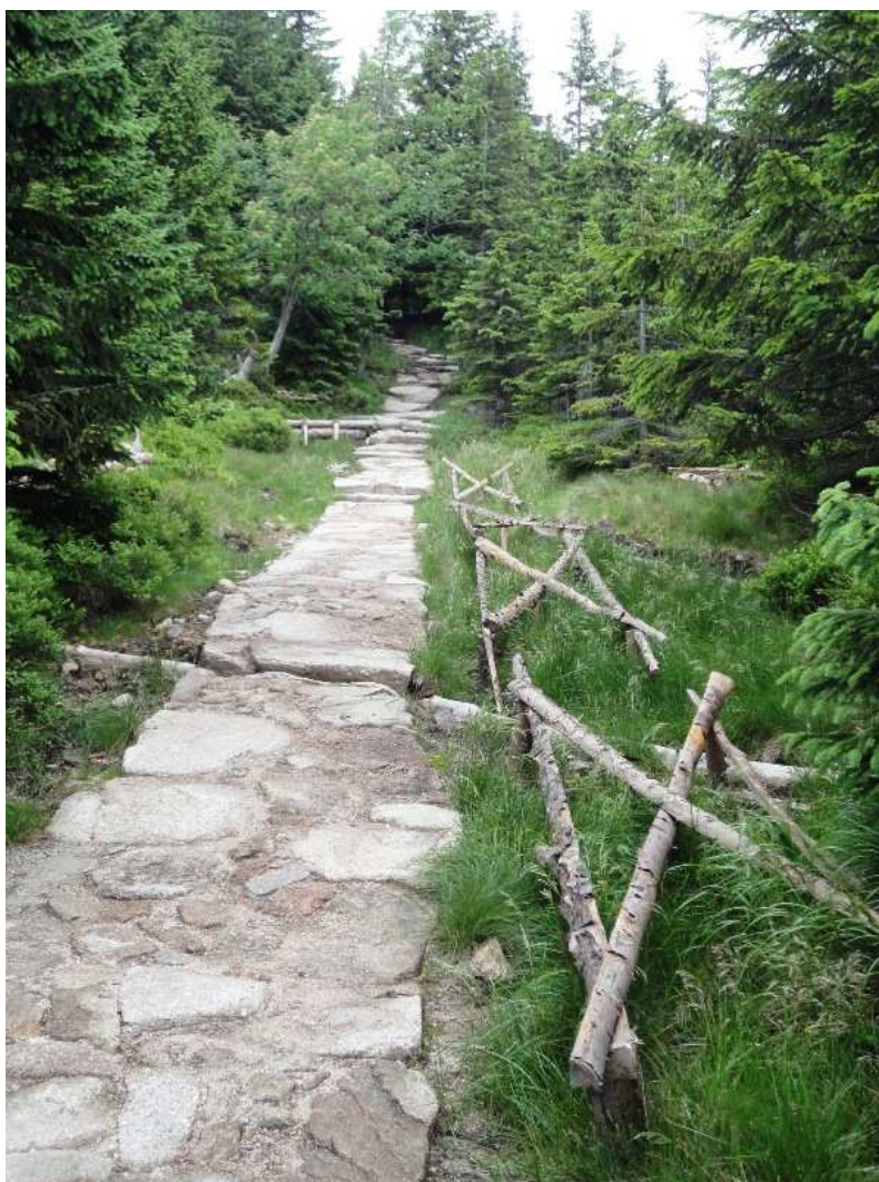
Fot.13. Zabezpieczenie poboczy szlaku przed rozdeptywaniem – potykacze.
