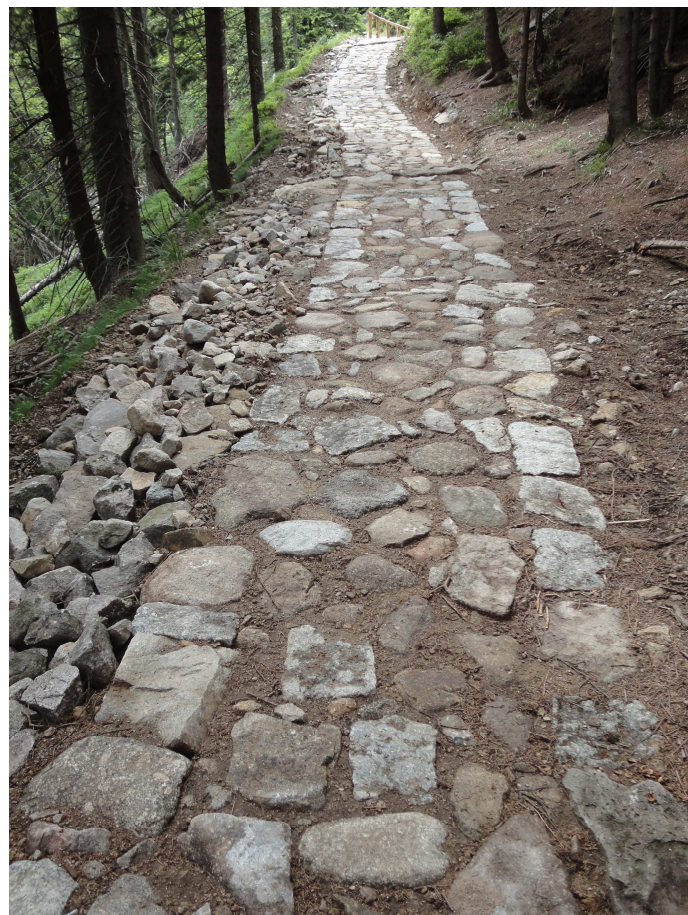
Fot. 11. Zabudowa pobocza drobnym kamieniem z rozbiórki nawierzchni.
