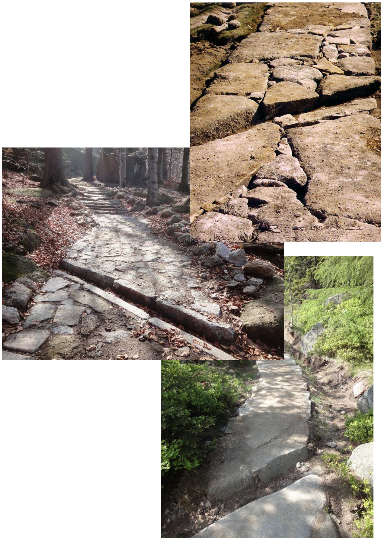
Fot.22, 23 i 24. Przykładowe rozwiązania przepustów kamiennych odkrytych.
