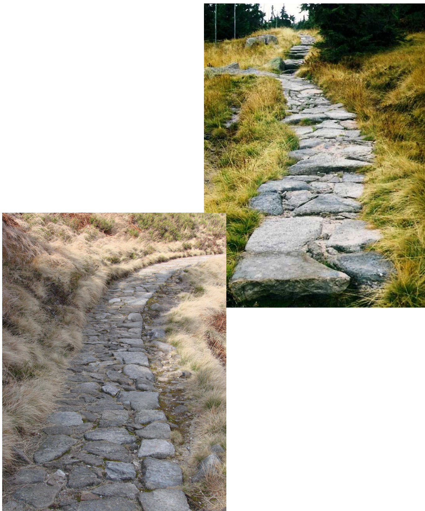
Fot. 16, 17, 18, 19, 20 i 21. Przykładowe rozwiązania przy odbudowie nawierzchni brukowanej kamieniem miejscowym.
