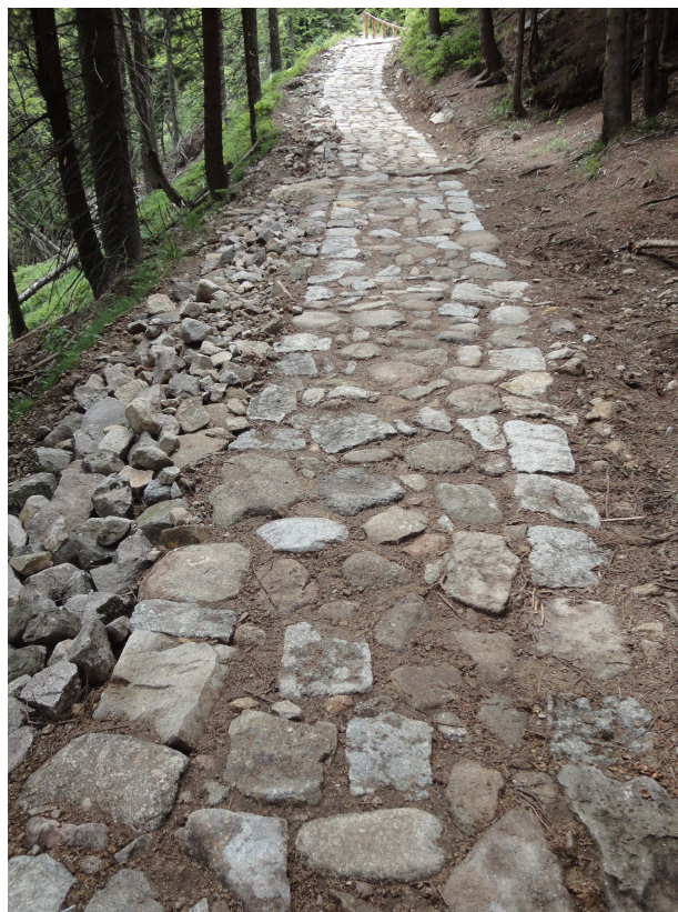
Fot.26. Zabudowa pobocza drobnym kamieniem z rozbiórki nawierzchni.
