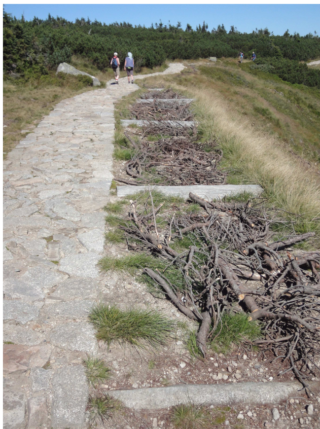
Fot.27. Zabezpieczenie poboczy; zabudowa przeciwierozyjna i suche gałęzie.
