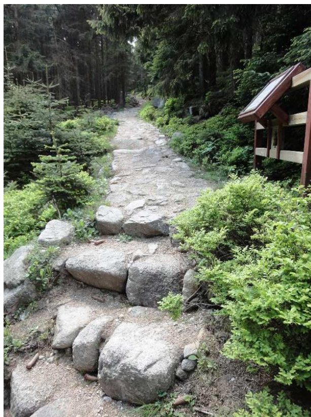
Fot.25. Stopnie terenowe z kamienia.
