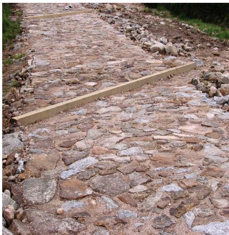
Fot.29. Progi drewniane wbudowane w nawierzchnię.
