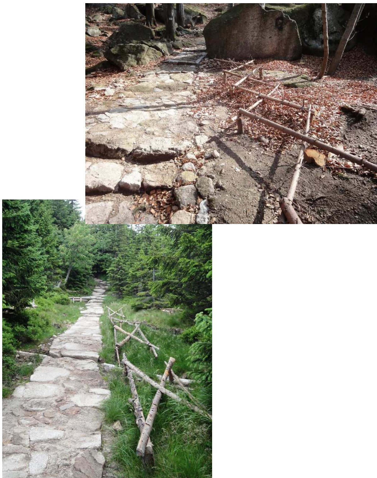
Fot.28. Zabezpieczenie poboczy szlaku przed rozdeptywaniem – potykacze.
