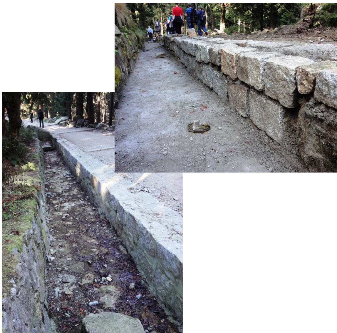
Fot. 1 i 2. Mury oporowe z kamienia łupanego na zaprawie cementowej wzmacniające koronę drogi.
