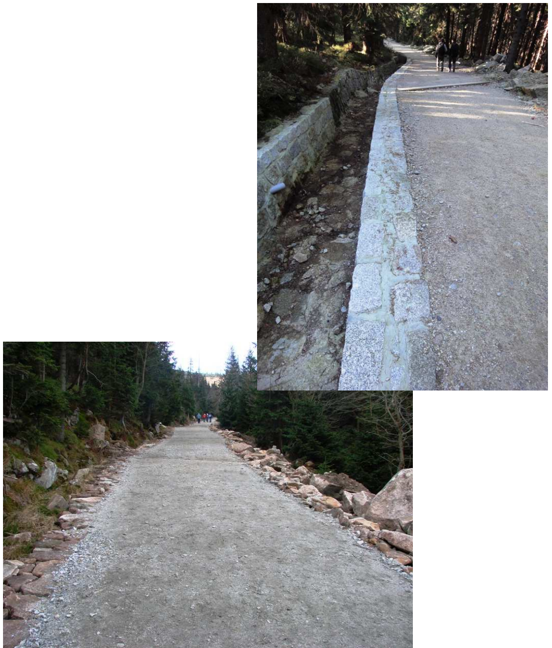
Fot. 6 i 7. Przykład nawierzchni tłuczniowej; uzupełnienie przy murze oporowym z kamienia i nawierzchnia tłuczniowa na całej szerokości szlaku..
