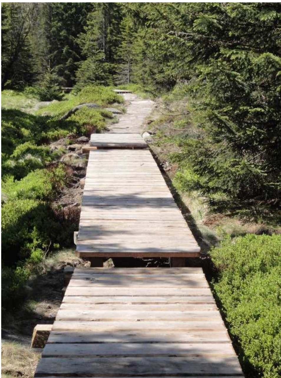
Fot. 29. Przykładowe rozwiązania – pomosty i kładki drewniane.
