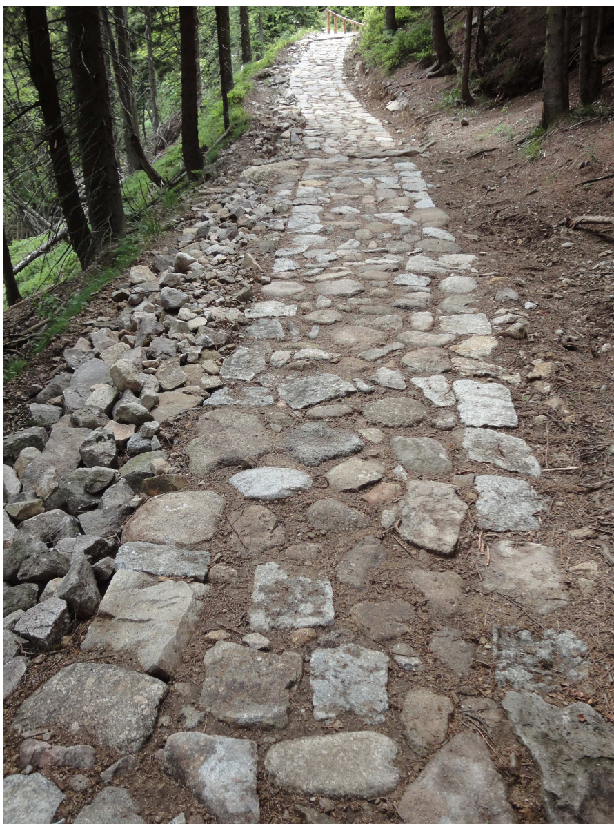
Fot.30. Zabezpieczenie poboczy szlaku drobnym kamieniem.
