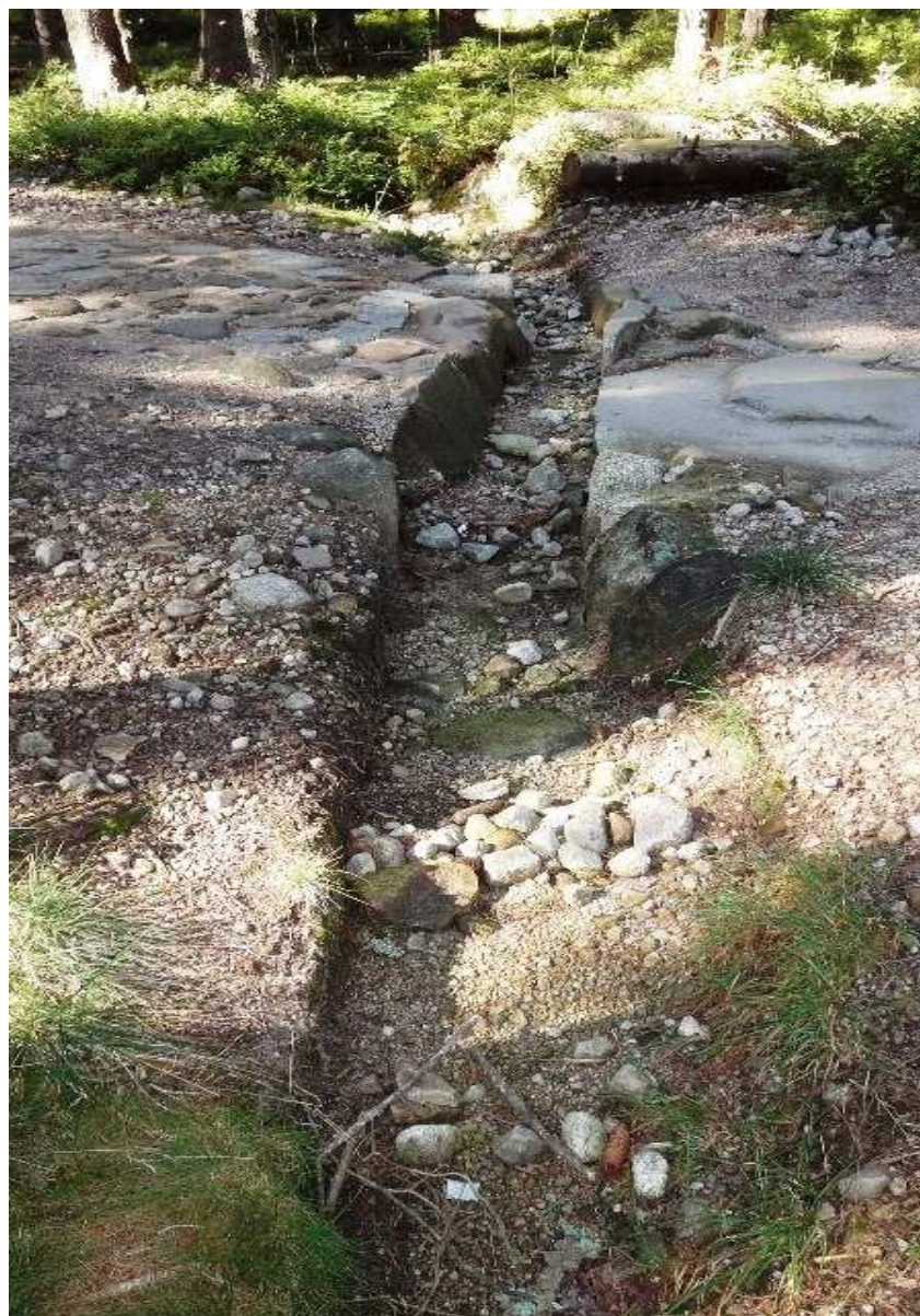
Fot. 4 . Udrożnione i odbudowane przepusty kamienne – odkryte wraz z rowami odprowadzającymi wodę.
