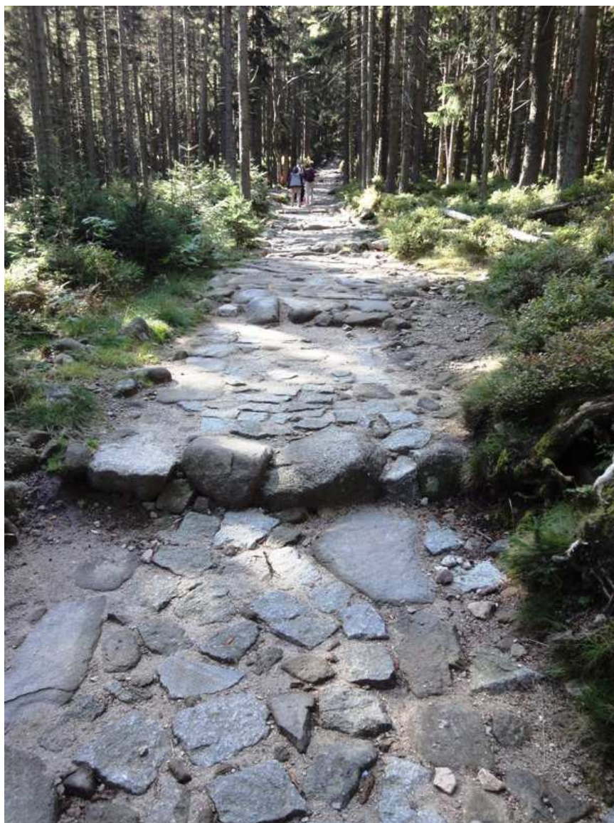
Fot.1, 2 i 3. Remontowany w latach poprzednich odcinek szlaku przy Kozim Mostku. Odbudowana brukowana nawierzchnia szlaku z kamienia miejscowego.
