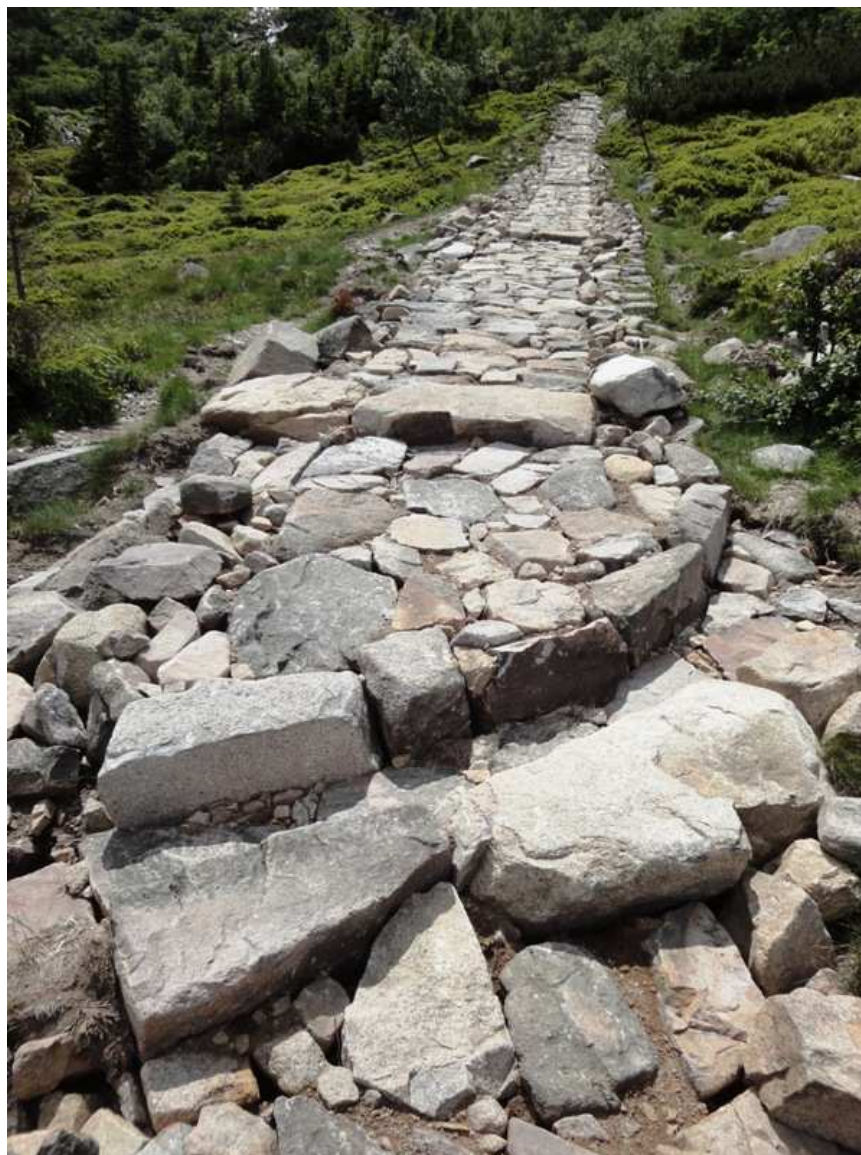
Fot. 28. Przykładowe rozwiązania przepustów kamiennych odkrytych.
