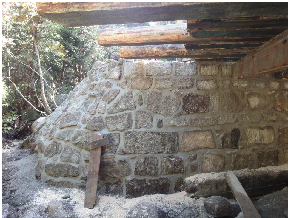
Fot.14. Oczyszczone i wyspoinowane przyczółki z kamienia.
