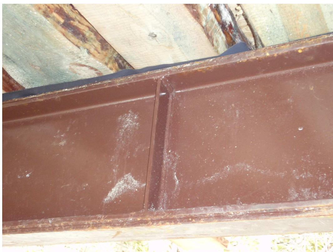
Fot.11. Usztywnienie środka z płaskownika 60x12 mm – co 150 cm.
