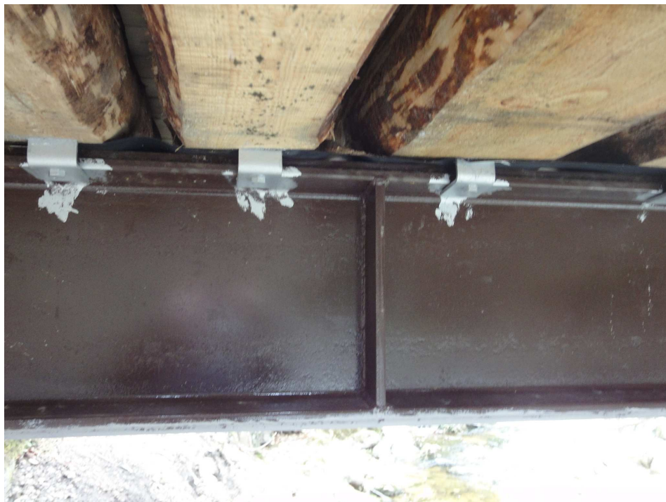
Fot.12. Montaż nośnych pomostu jezdnego z belek drewnianych.
