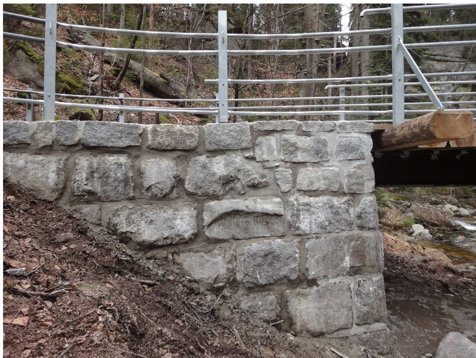
Fot.13. Murki oporowe najazdowe z kamienia na zaprawie cementowej.
