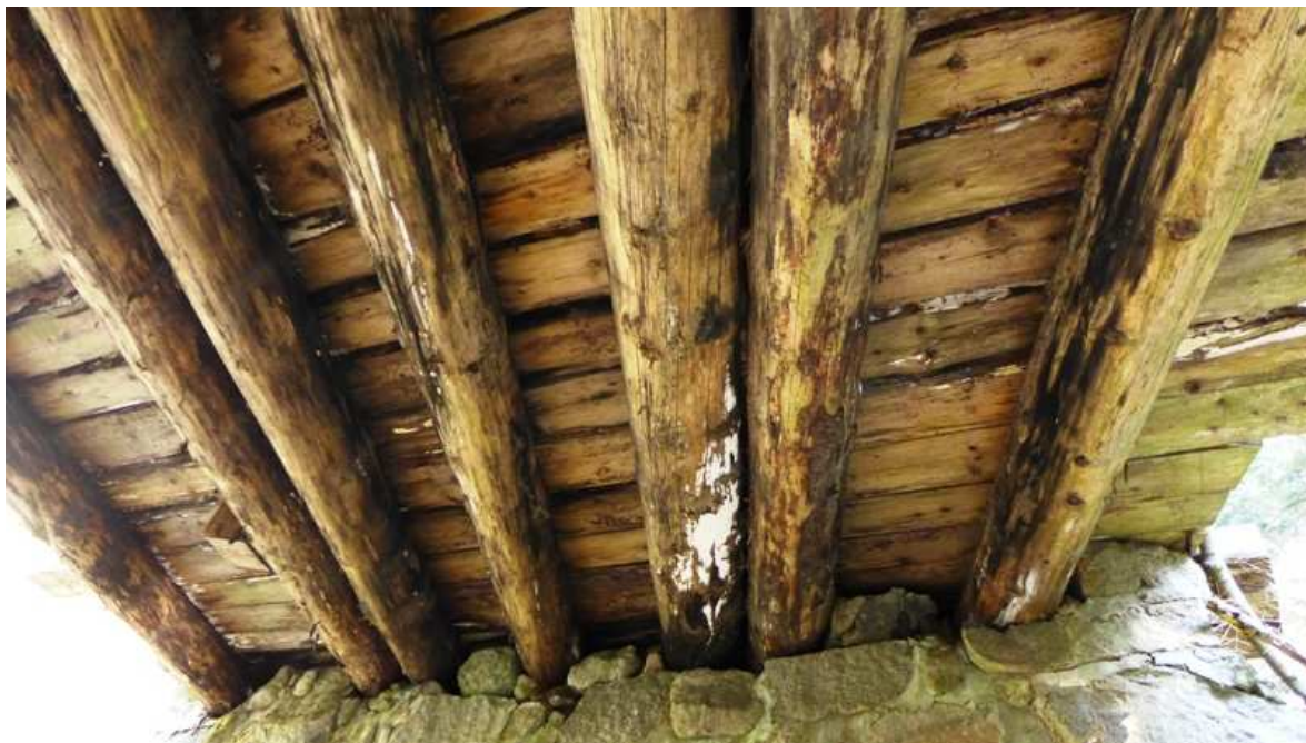
Fot.2. Drewniane belki nośne mostu.
