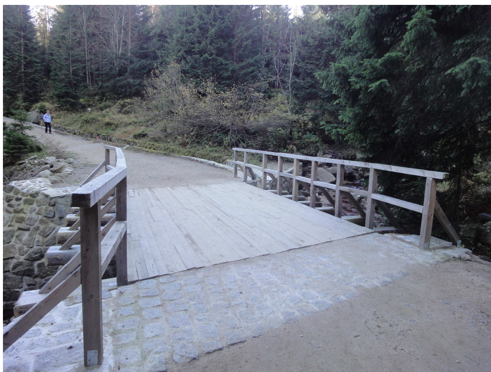
Fot.15. Płyta najazdowa – okładzina z kostki granitowej na zaprawie cementowej.
