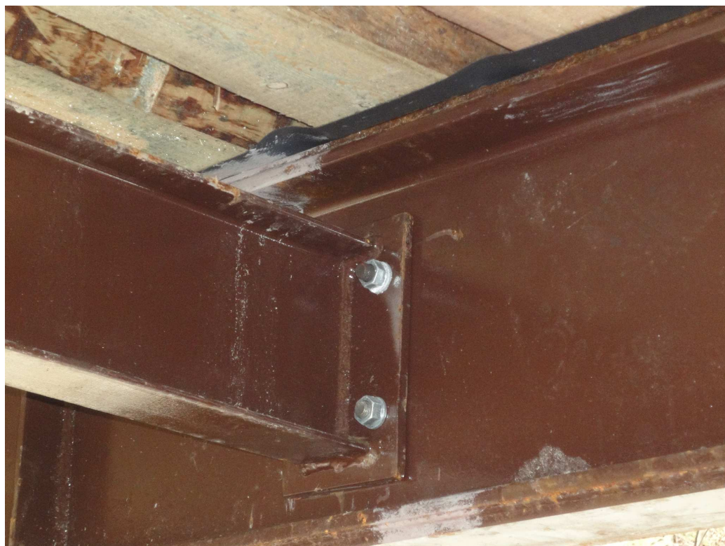
Fot.10. Mocowanie stężeń poprzecznych do belek nośnych.
