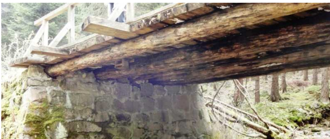
Fot.5. Drewniany pomost jezdny.
