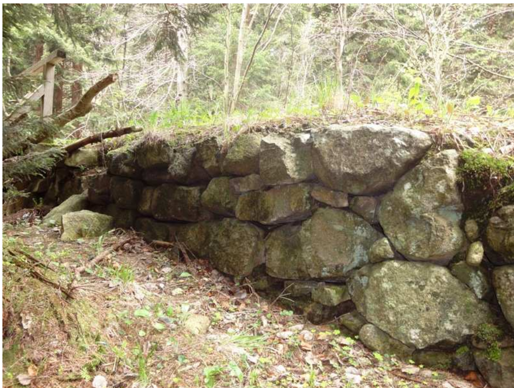
Fot. 7, 8 i 9. Mury najazdowe na przyczółki z kamienia rodzimego ułożonego na sucho.
