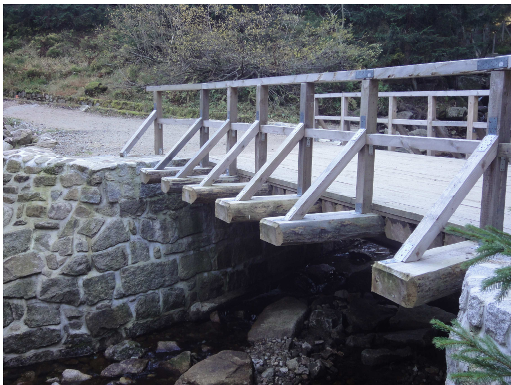
Fot.16. Balustrada drewniana.
