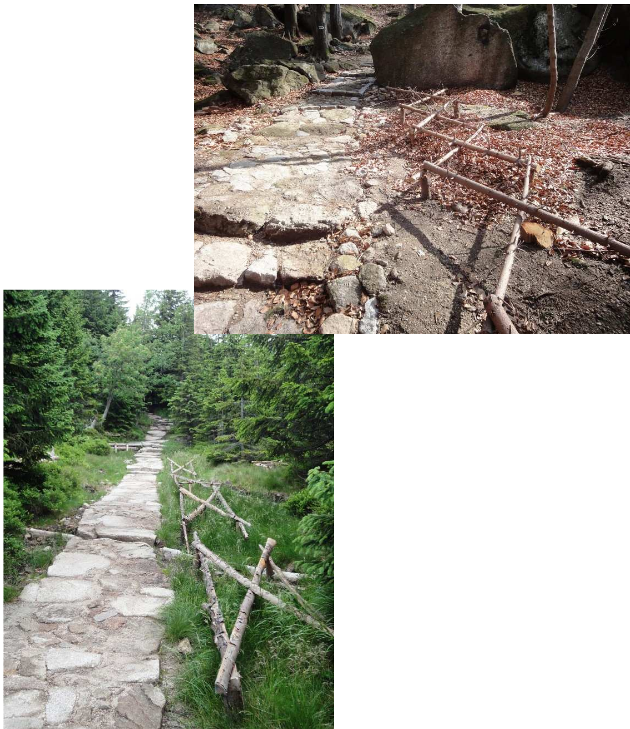
Fot.27. Zabezpieczenie poboczy szlaku przed rozdeptywaniem – potykacze.
