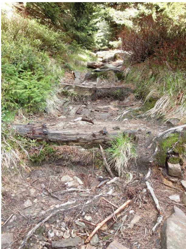
Fot.10, 11, 12 i 13. Zniszczone progi i stopnie, zarośnięte rowy.
