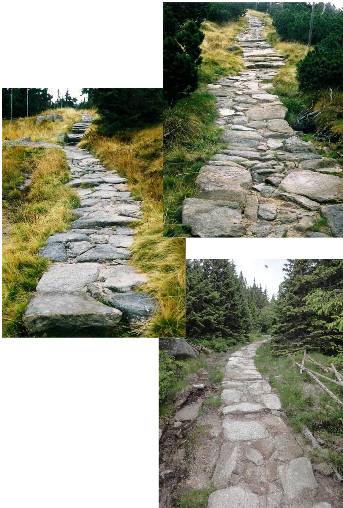
Fot.18, 19, 20, 21, 22 i 23. Przykładowe rozwiązania przy odbudowie nawierzchni brukowanej kamieniem miejscowym.
