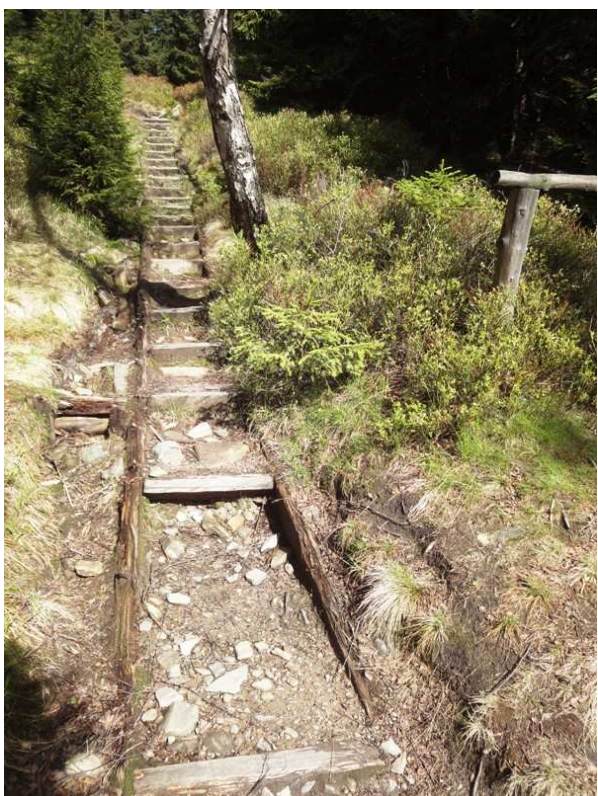
Fot.3, 4, 5 i 6. Zniszczona nawierzchnia szlaku łącznie z elementami drewnianymi, które wzmacniały nawierzchnię i ułatwiały pokonywanie stromizny.
