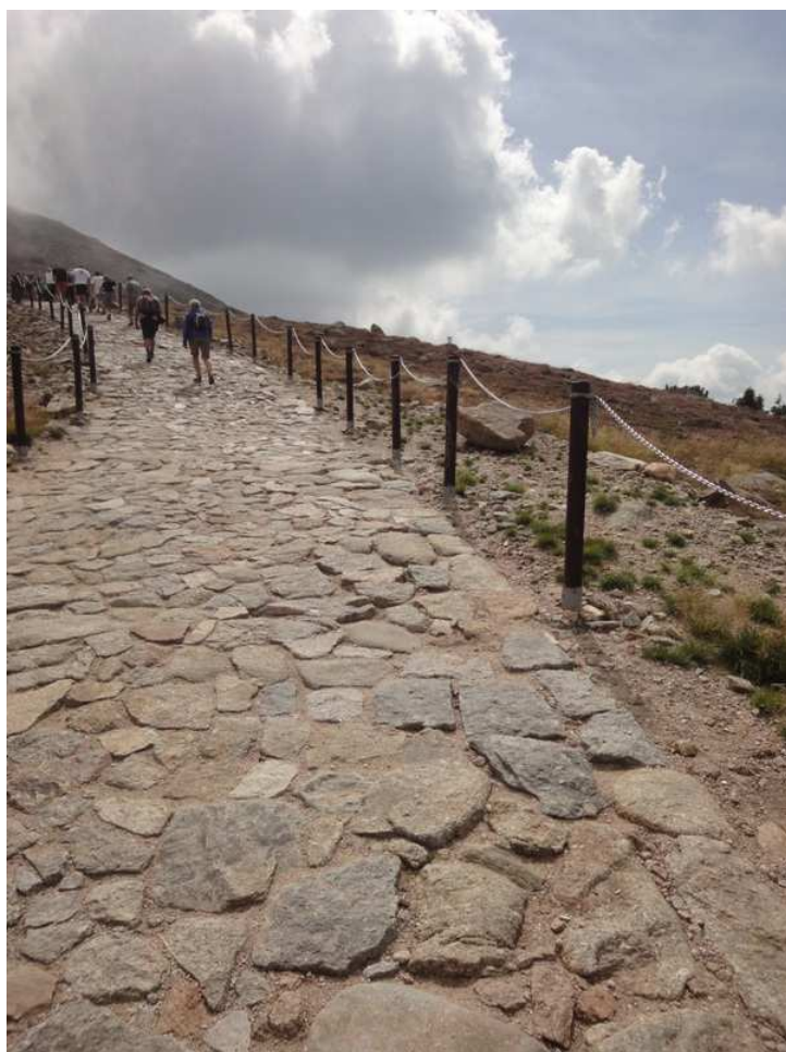
Fot. 23. Nawierzchnia brukowana kamieniem miejscowym z rozbiórki.
