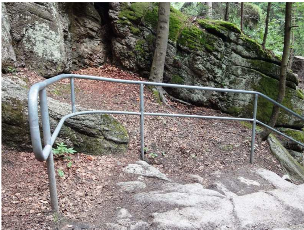
Fot.24. Balustrady z rur stalowych ocynkowanych.
