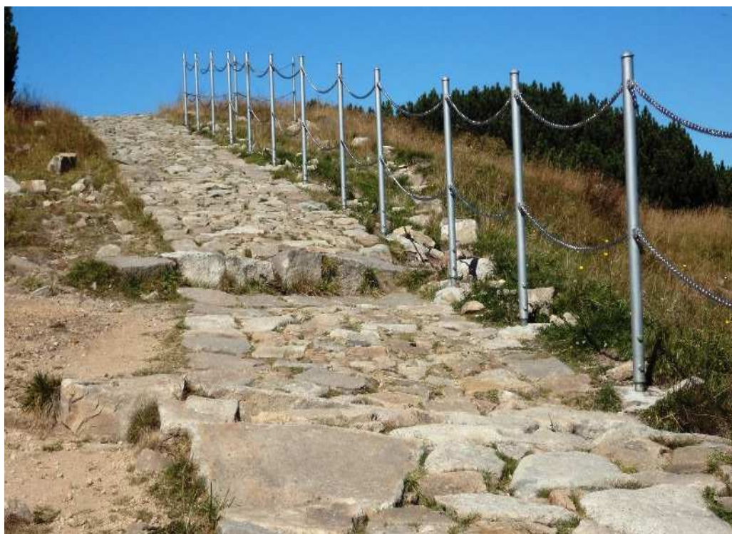
Fot.20. Słupek z rur ocynkowanych, przymocowany śrubami do osadzonego trwale w gruncie trzpienia.
