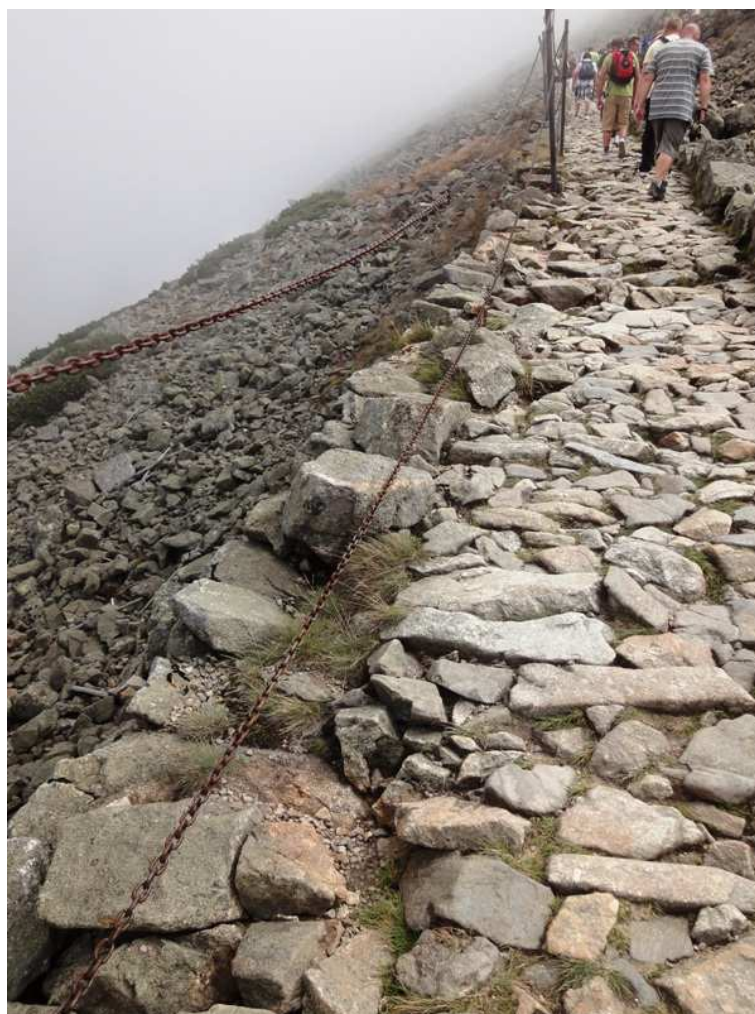
Fot.13 i 14. Resztki muru oporowego z kamienia miejscowego ułożonego na sucho.
