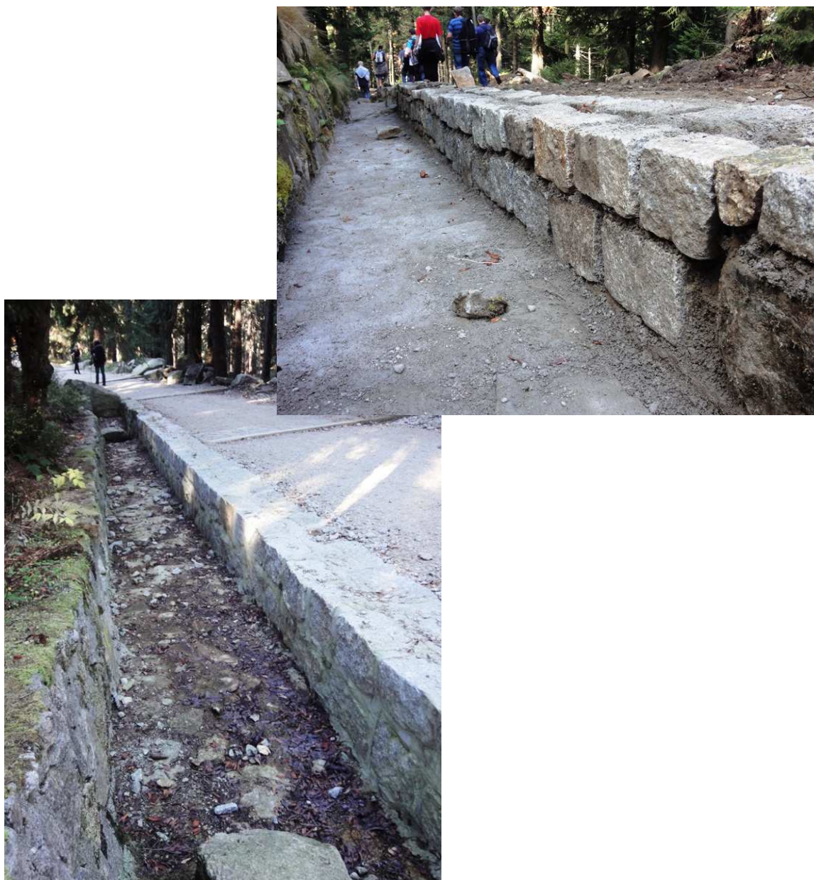
Fot. 1 i 2. Mury oporowe z kamienia łupanego na zaprawie cementowej wzmacniające koronę drogi.
