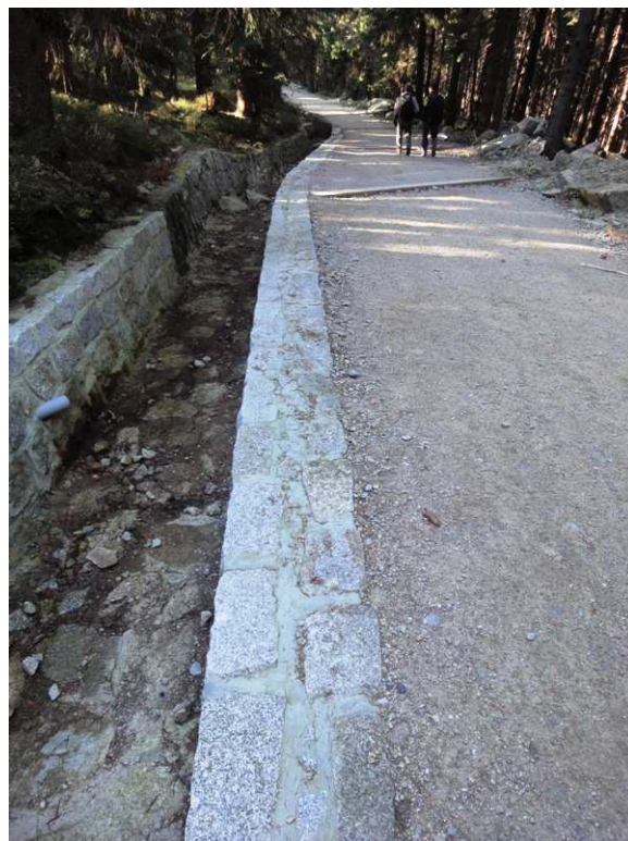
Fot. 7. Przykład uzupełnienia nawierzchni tłuczniowej przy murze oporowym z kamienia.
