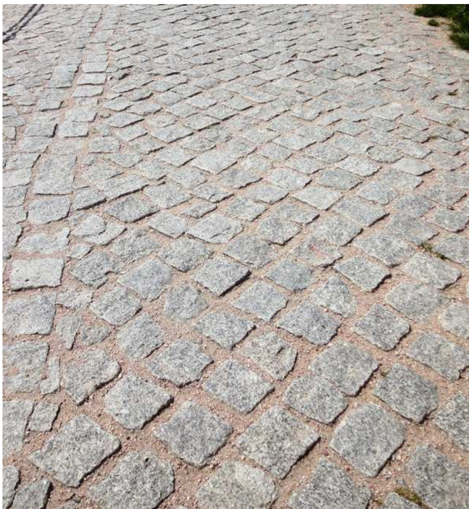
Fot.13. Nawierzchnia brukowana (granit)
