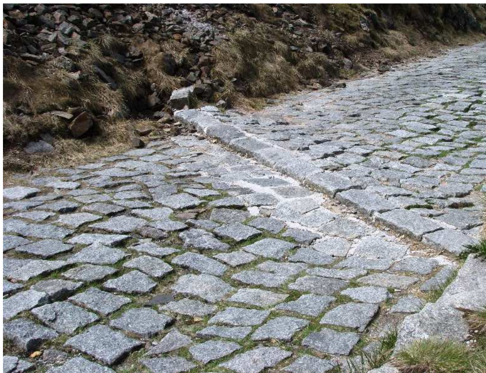
Fot.12. Próg kamienny wbudowany w nawierzchnię brukową.
