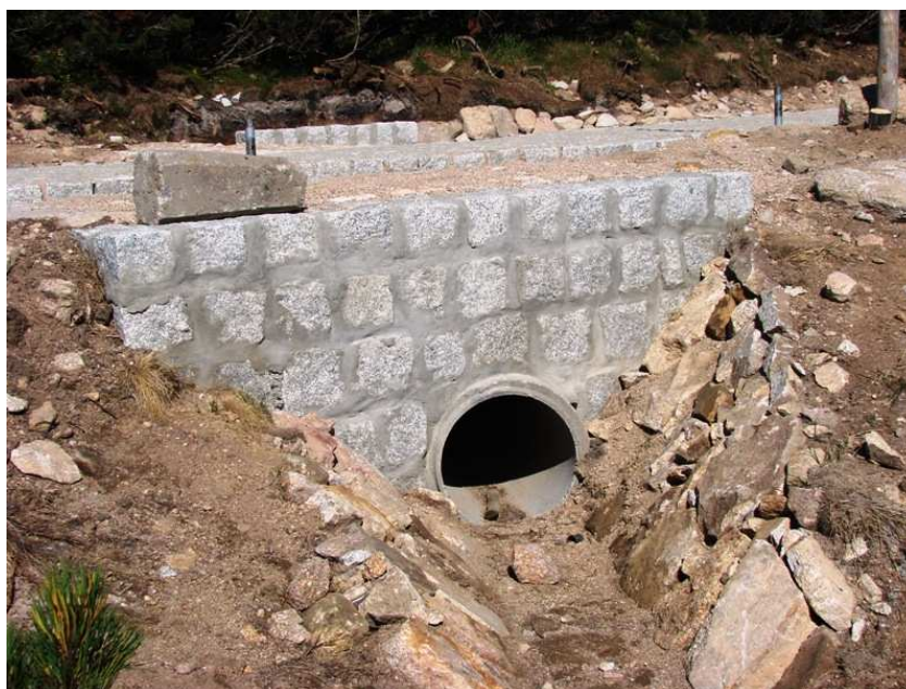
Fot. 5. Przepusty rurowe; wylot z przepustu wraz z umocnieniem rowu odprowadzającego wodę kamieniem miejscowym.
