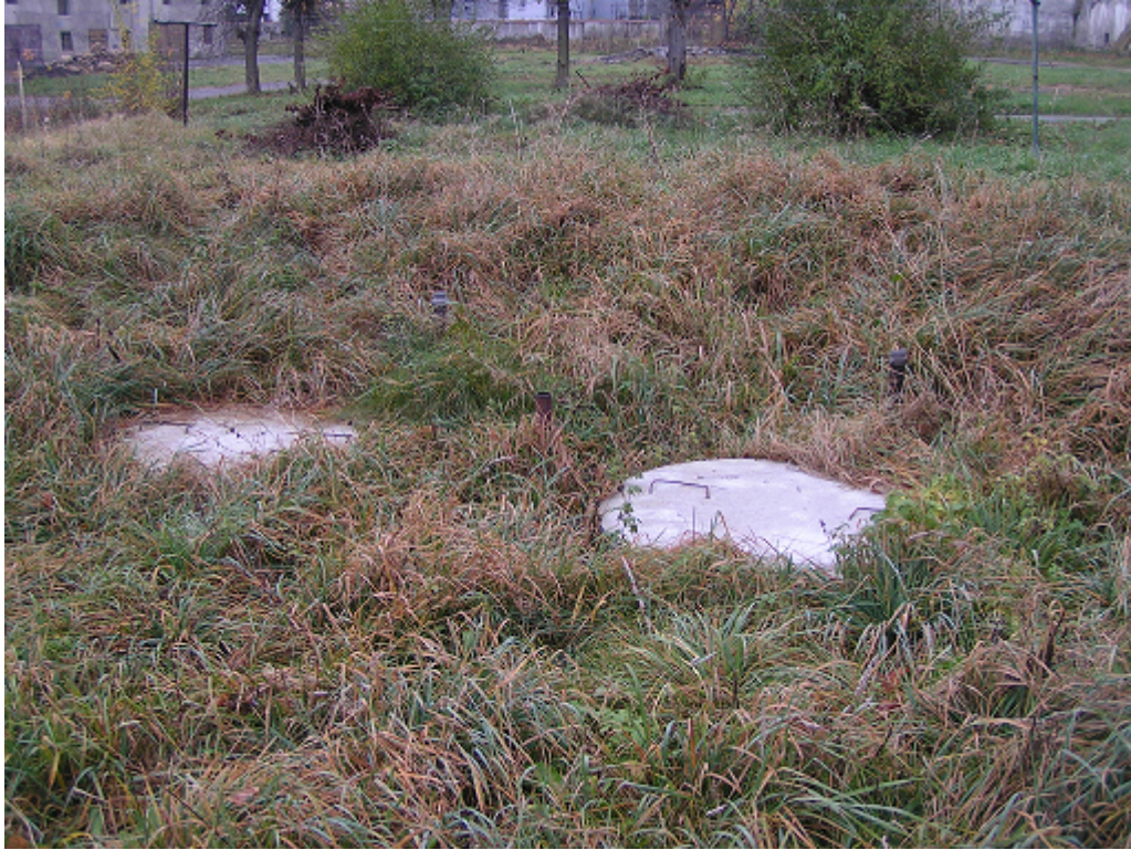
Fot. 3. Włazy wlotowe do zbiorników
