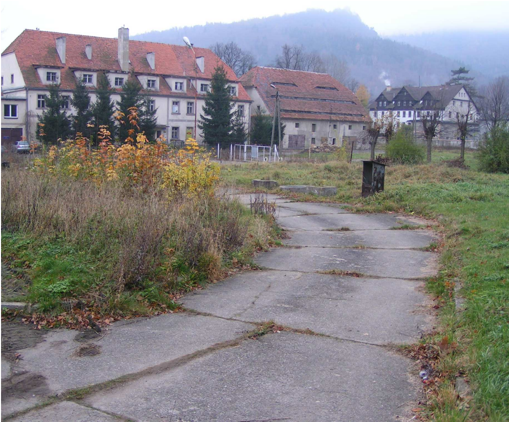
Fot. 1. Droga wjazdowa do pozostałości po stacji paliw
