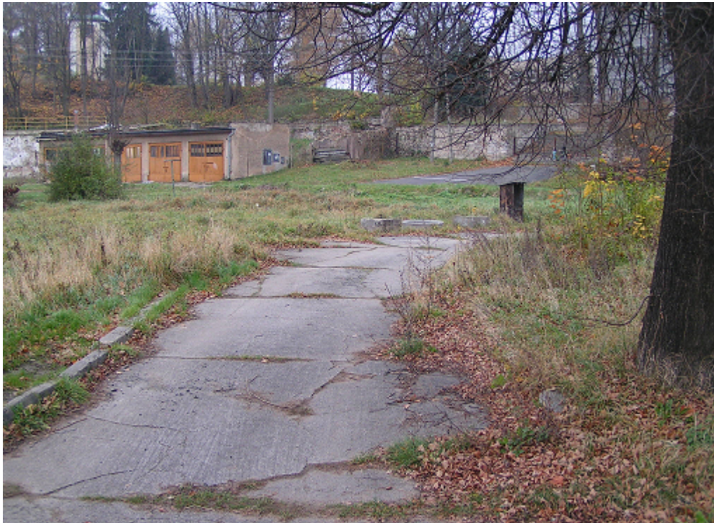
Fot. 2. Droga wyjazdowa z pozostałości po stacji paliw
